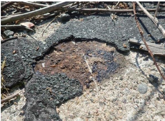
Kuva 5.21. Näyte 22, betonikansi ulkovaras- ton vieressä. Bitumikate.
