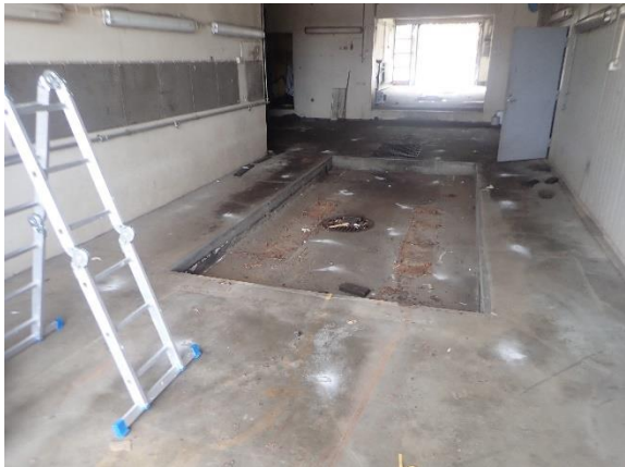
Kuva 5.23. Huoltohalli, laajennusosa. Näyte 13 ÖLJY.
