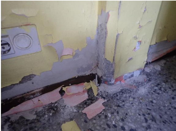
Kuva 5.11. Näyte 06, matkahuolto. Pilarin ja väliseinän maali ja tasoite.
