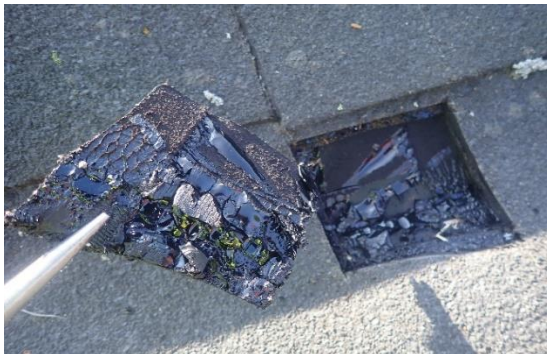
Kuva 5.22. Näyte 20, vesikatto. Vesikaton alempi bitumikermi ja -massa.
