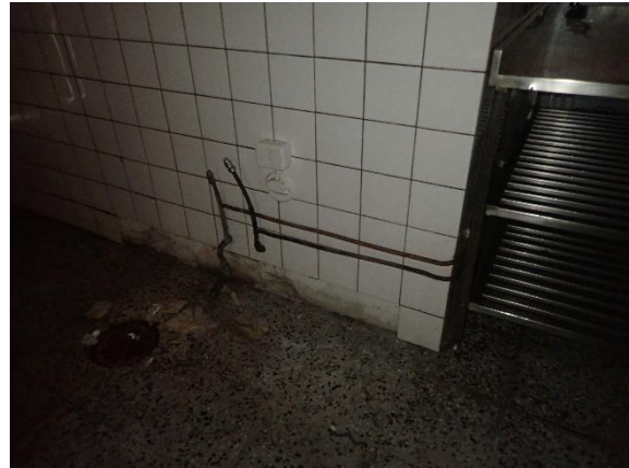
Kuva 5.12. Näyte 08, keittiö. Väliseinän laatoitus ja laastit.
