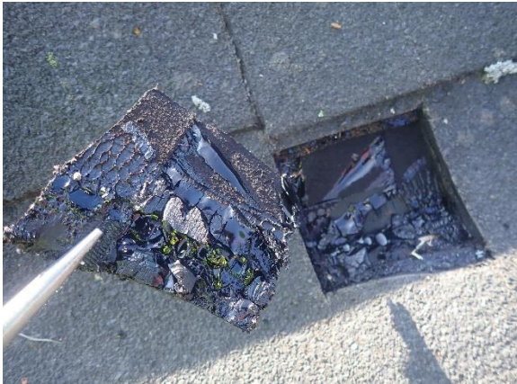
Kuva 5.19. Näyte 20, vesikatto. Vesikaton alempi, mahdollisesti vanhempi, bitumiker- mi ja -massa.
