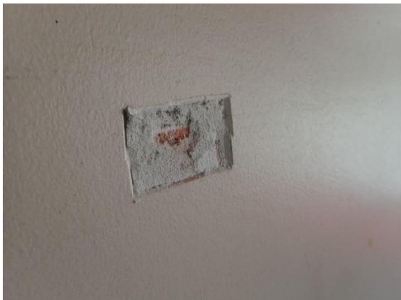
Kuva 5.7. Näyte 01, myymälä. Ulkoseinän maali ja tasoite.
