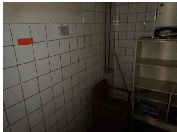
Kuva 5.8. Näyte 02, sosiaalitila M. Väliseinän laatta ja laastit.
