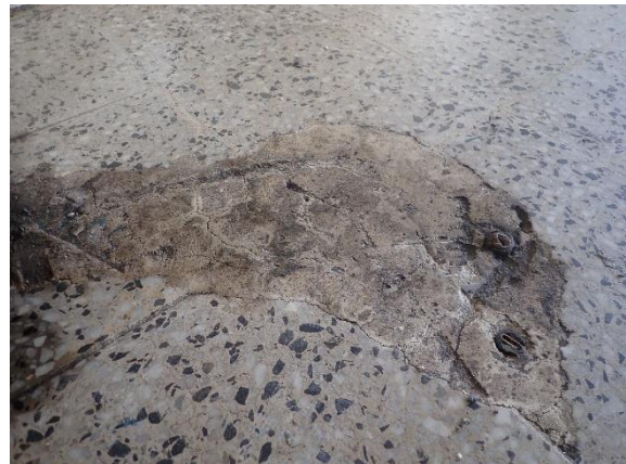
Kuva 5.10. Näyte 04, ravintola. Lattian korjausmassa.
