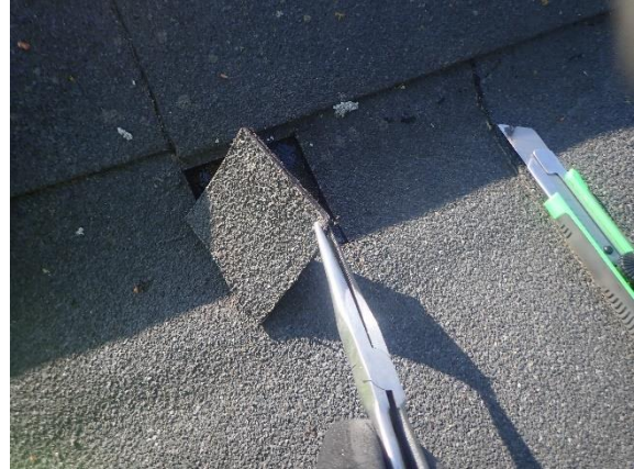
Kuva 5.18. Näyte 19, vesikatto. Bitumiker- mi, ylempi kerros.
