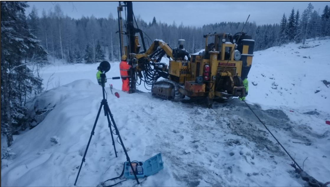
Kuva 3 Mittauspiste MP1. Louhinnan porausvaiheen äänitasomittaus 17.1.2017 Tervakallion kallioalueella.
