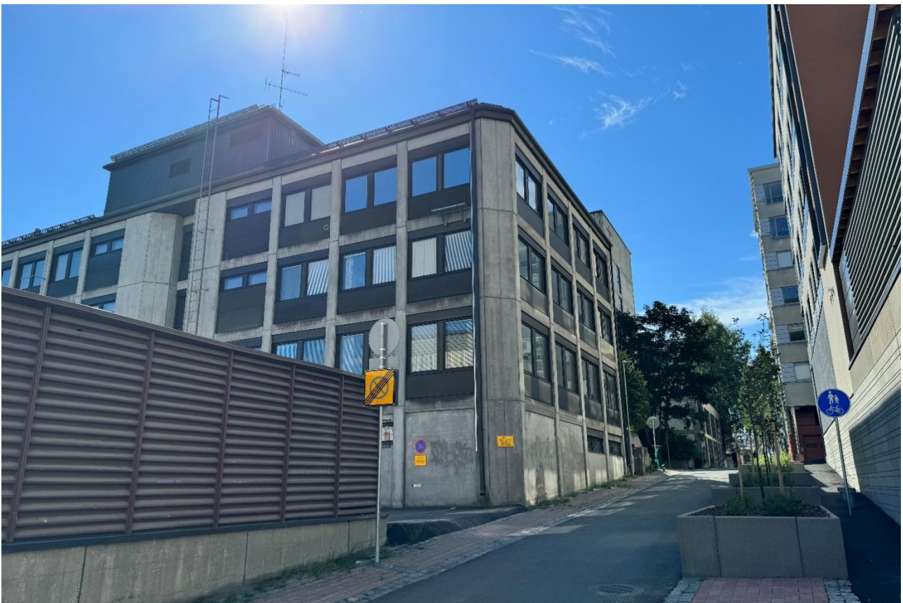
Kuva 8. Oleva vuonna 1982 valmistunut liike- ja toimistorakennus kuvattuna Käsityökadulta 7/2024
