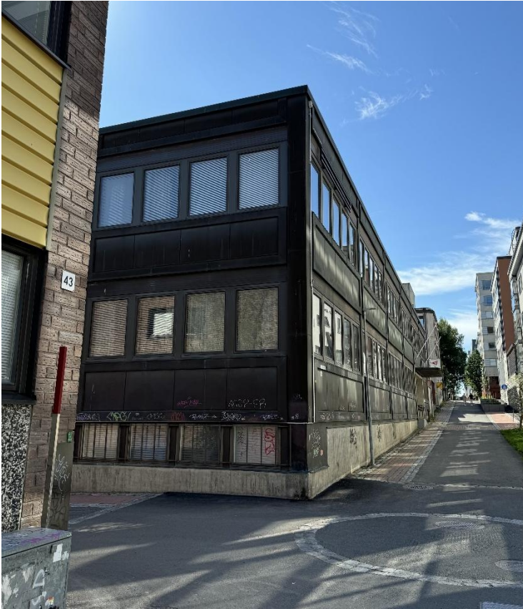
Kuva 3. Oleva vuonna 1974 valmistunut toimistorakennus kuvattuna Käsityökadulta 7/2024
