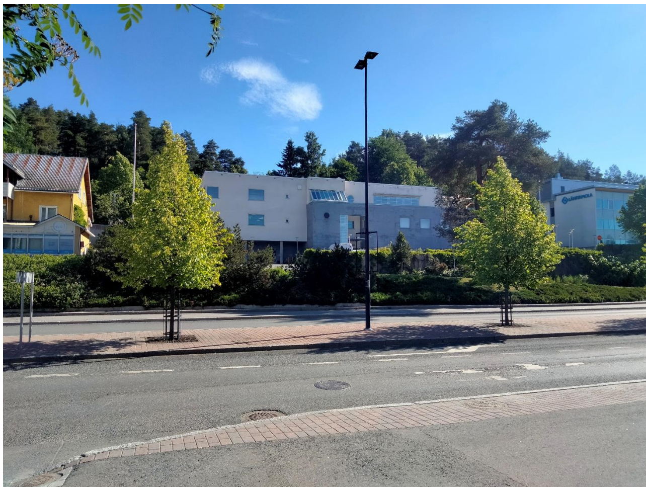
Kuva 2. Entinen Suomen Pankin rakennus lounaan suunnalta kuvattuna.
