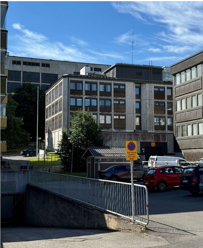
Kuva 4. Oleva vuonna 1982 valmistunut liike- ja toimistorakennus kuvattuna Hapelähteenkadulta 7/2024
