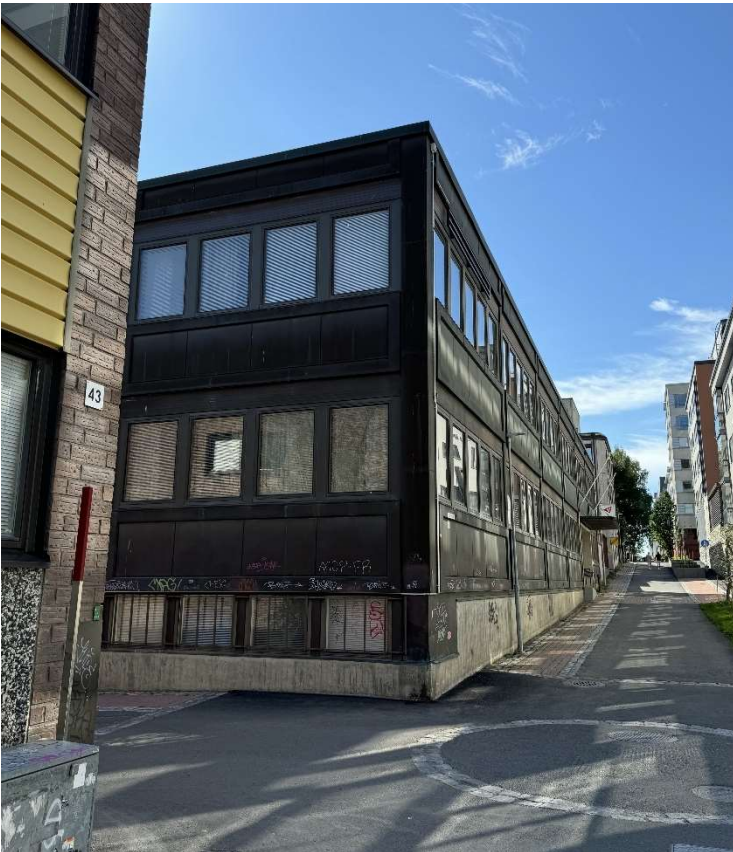
Kuva 6. Oleva vuonna 1974 valmistunut toimistorakennus kuvattuna Käsityökadulta 7/2024
