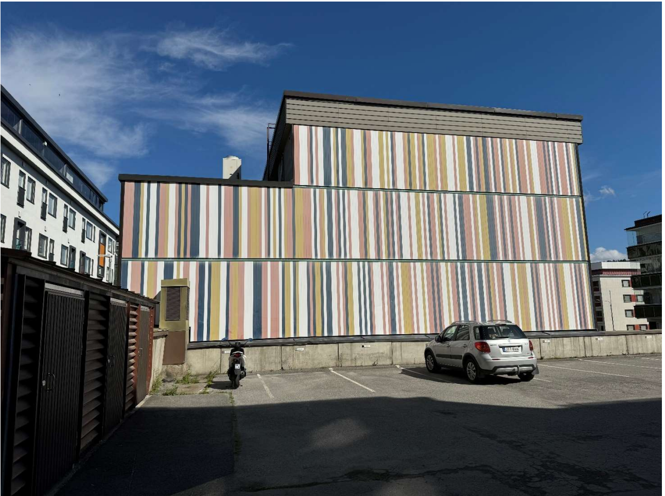
Kuva 8. Vuonna 1974 valmistuneen toimistorakennuksen eteläpäädyssä oleva Mauri Favénin tekemä seinämaalaus 7/2024
