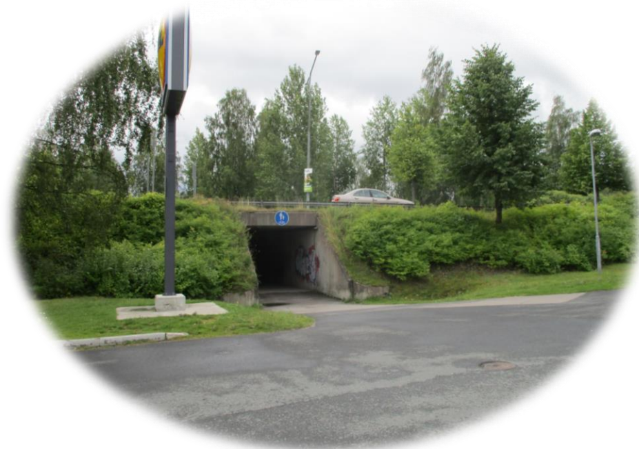
Kuva 12. Nykyinen alikulkukäytävä (S7)
