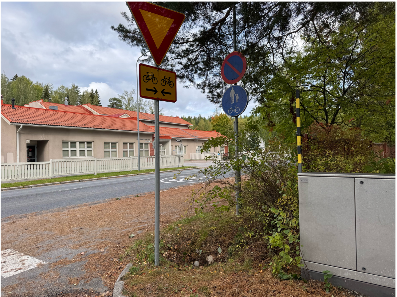
Kuvat 23.9.2025 Pitkälahdentien ja Maunolantien risteyksestä, jossa kaksisuuntainen pyörätie- jalankulkuväylä Pitkälahden koulun välittömässä läheisyydessä. Erittäin vaarallinen risteys, jossa
