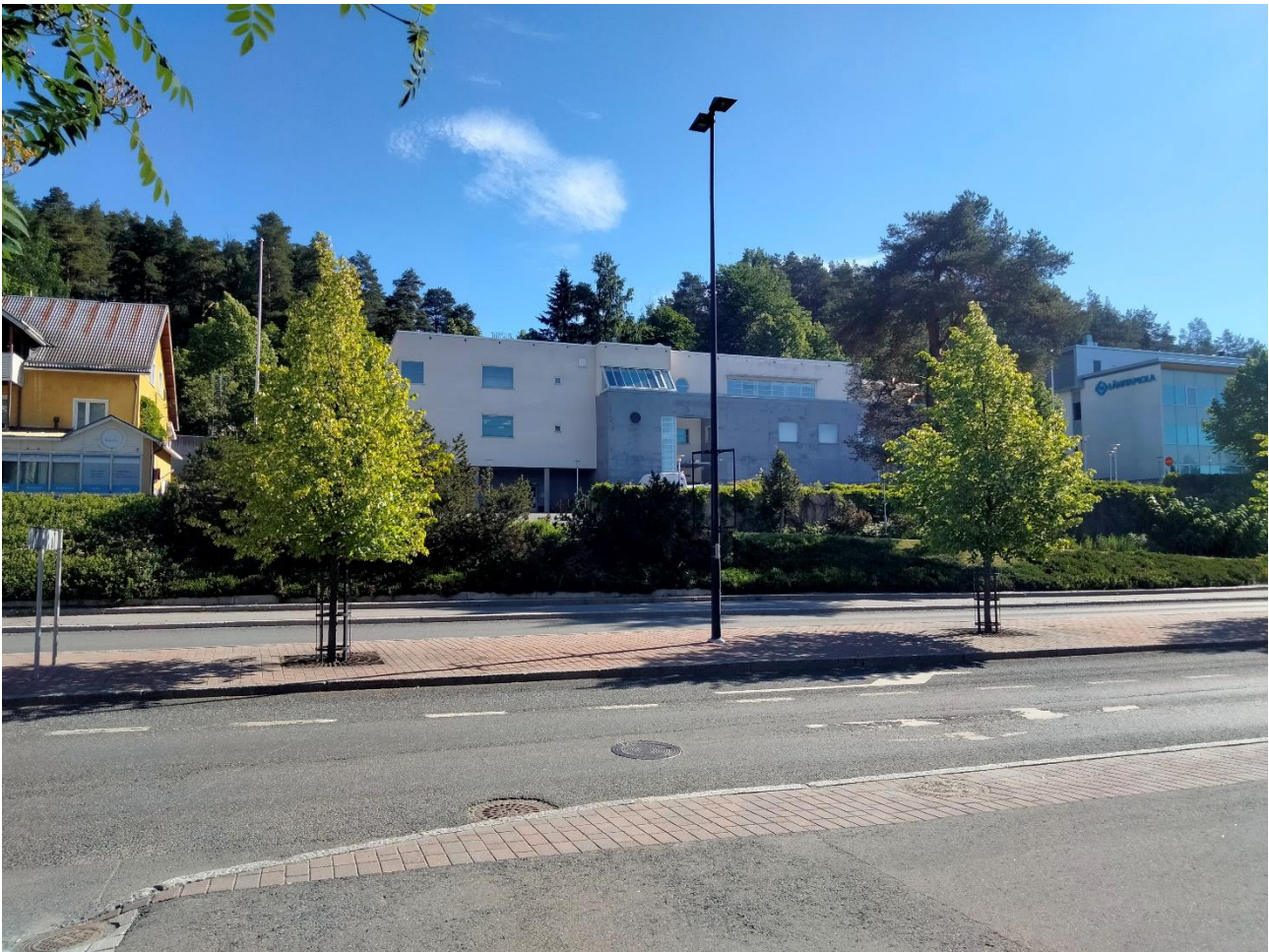
Kuva 2. Entinen Suomen Pankin rakennus lounaan suunnalta kuvattuna.
