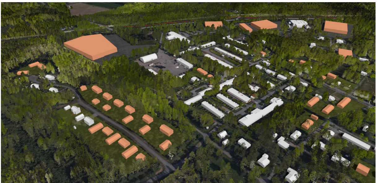
Kuva 7. Näkymä pohjoiseen, vasemmassa laidassa Kalliokuja ja uusi teollisuustontti
