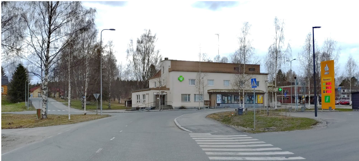
Kuva 23. Näkymä Kissakuusentien risteyksestä Pörönsolantien suunnasta, 50-luvun vaalean keltainen liikerakennus korostuu kaupunkikuvassa saavuttaessa Karttulaan.
