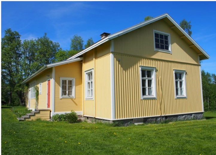
Kuva 12. Päärakennuksen kaakkoispääty ja lounaissivu.
