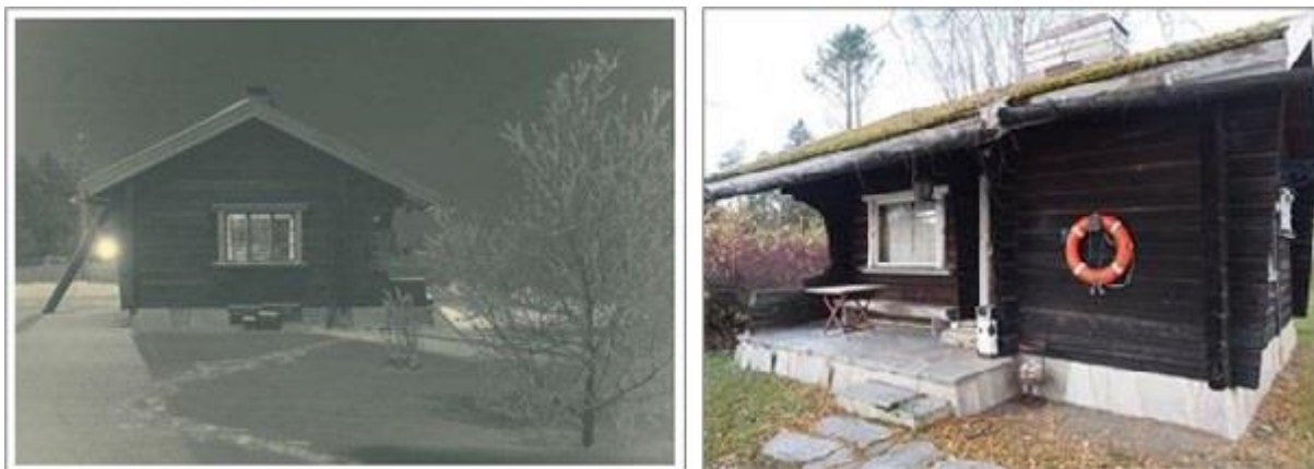
Kuva 13. Saunarakennus 1950-luvulla ja vuonna 2020. Lihakunnan kuva-arkisto / Aada Mustonen
