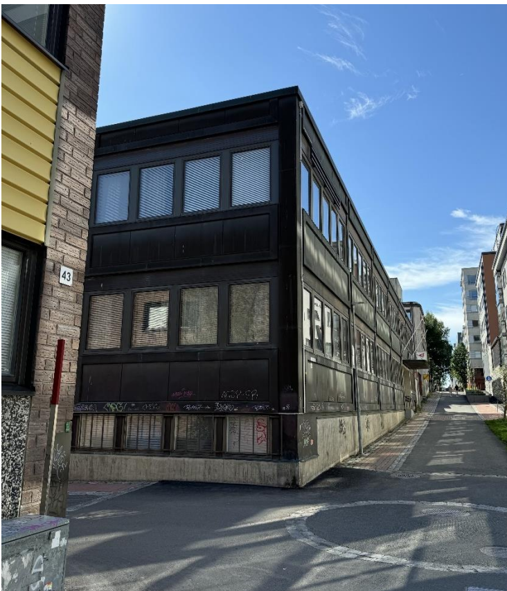
Kuva 6. Oleva vuonna 1974 valmistunut toimistorakennus kuvattuna Käsityökadulta 7/2024
