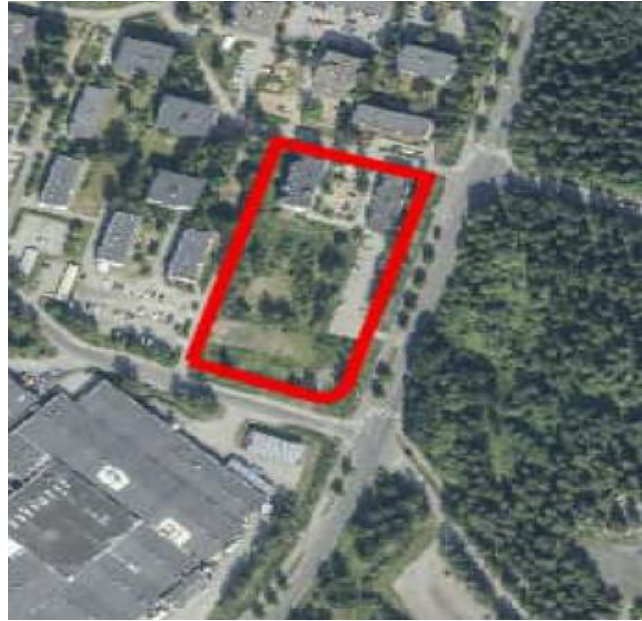
Kuva 2. Viistoilmakuva etelästä, likimääräinen kaavamuutosalue on merkitty punaisella viivalla
