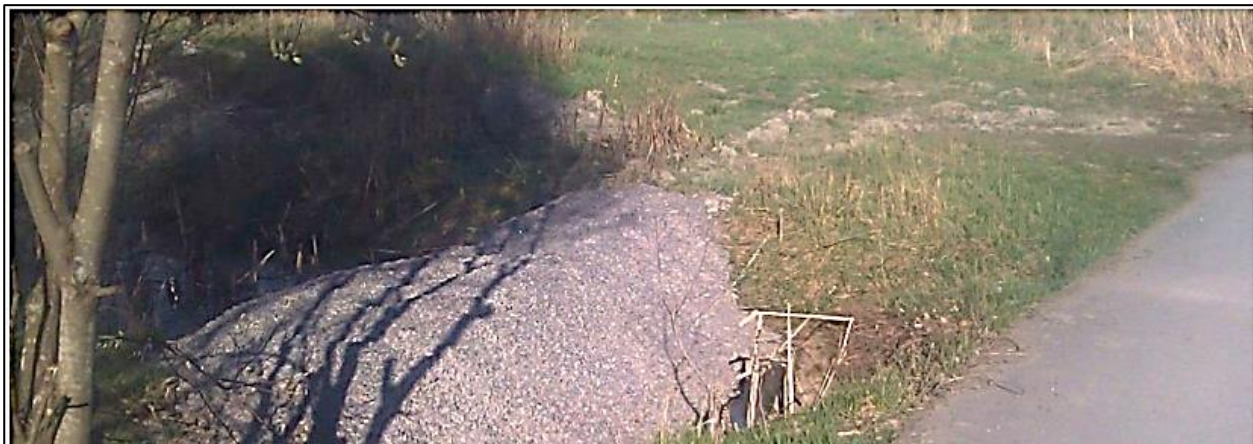
Kuva 18 Avo-ojan eteen rakennettu väliaikainen suodattava murskepato. Turku.
