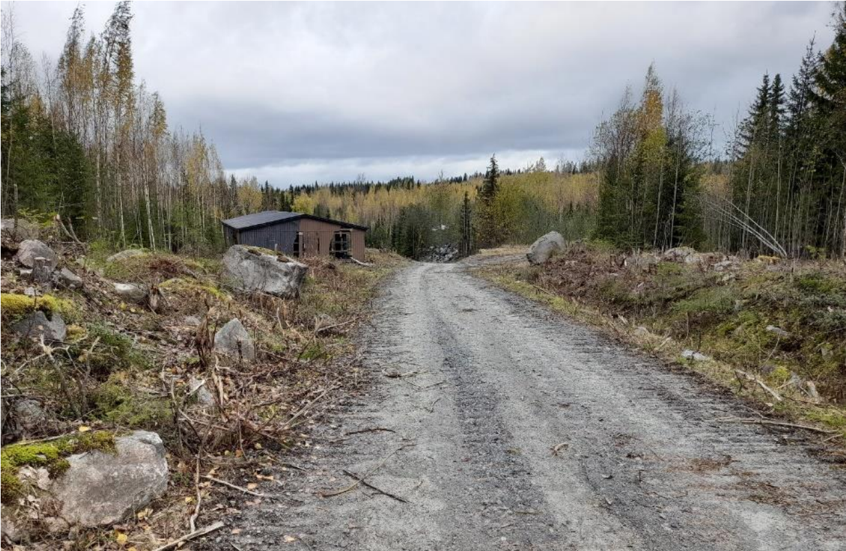
Kuva 4. Näkymä Asemavarikontien tulevalta katulinjalta. (Kuva: Anne Partanen 10/2023)
