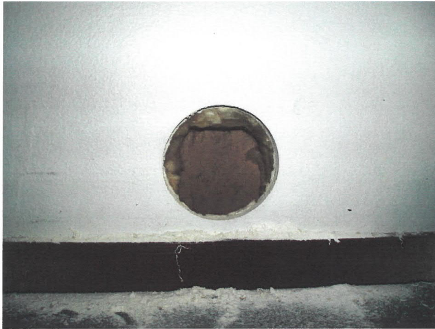
Kuva 4 Väliseinän rakenne
