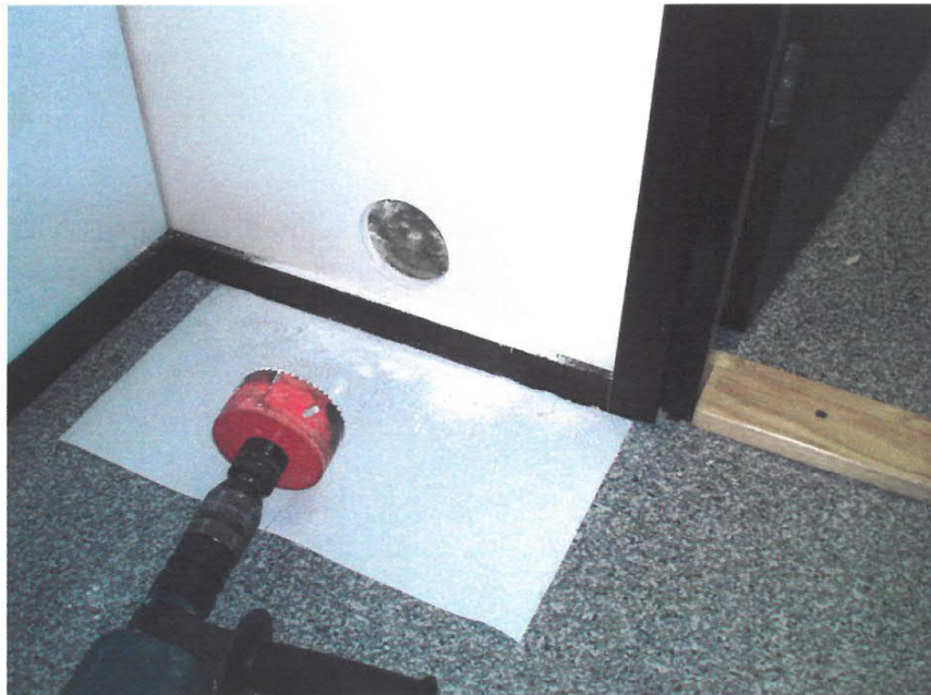
Kuva 7 Toimisto, nuorisosihteeri, rakenteen avauskohta
