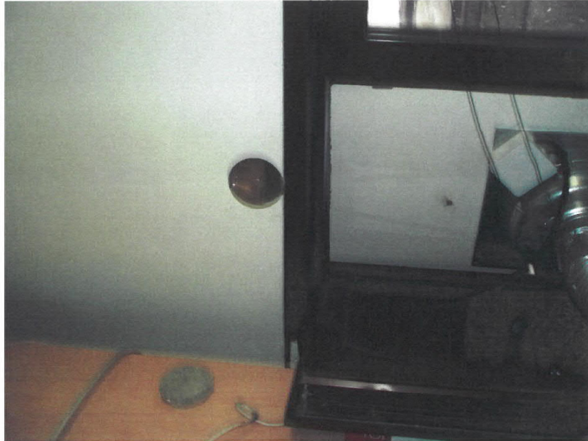
Kuva 1 Toimisto, Niskanen, rakenteen avauskohta
