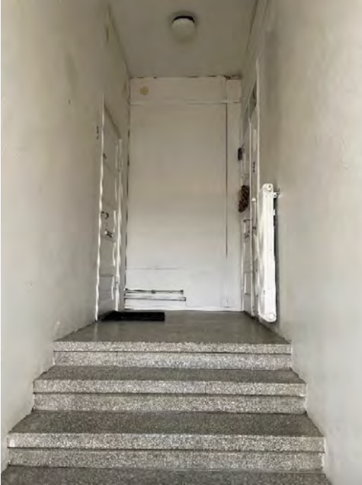
Porrashuone B, kuva K.H.
