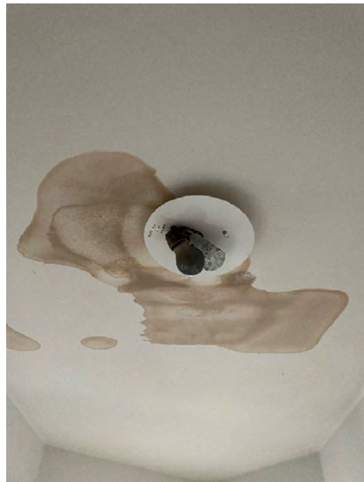
Katon vesivahinko, kuva K.H.
