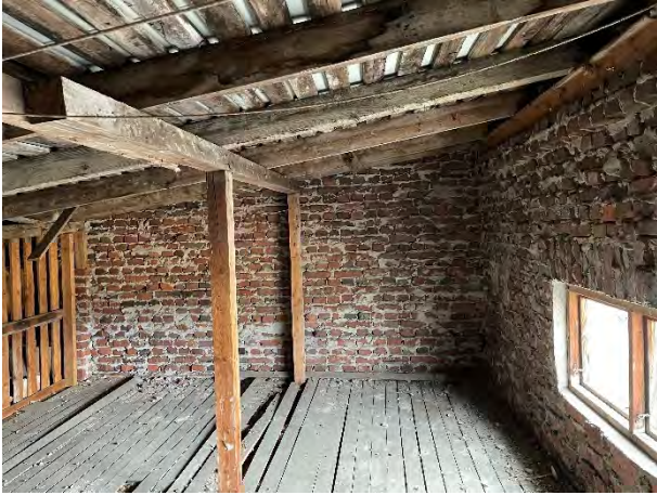
Ullakko Mustinlammenkadun puolella, kuva K.H.
