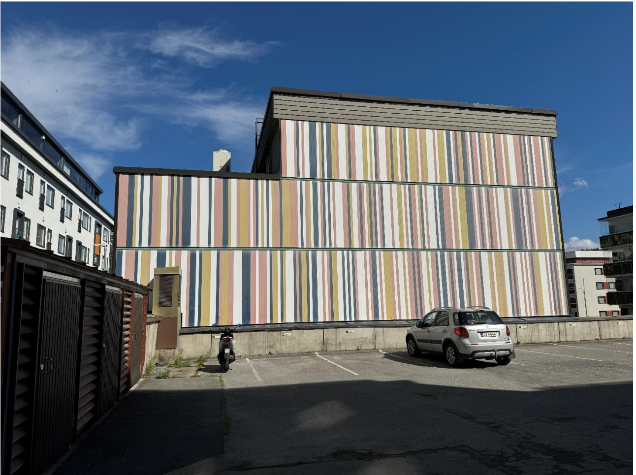
Kuva 8. Vuonna 1974 valmistuneen toimistorakennuksen eteläpäädyssä oleva Mauri Favenin tekemä seinämaalaus 7/2024
