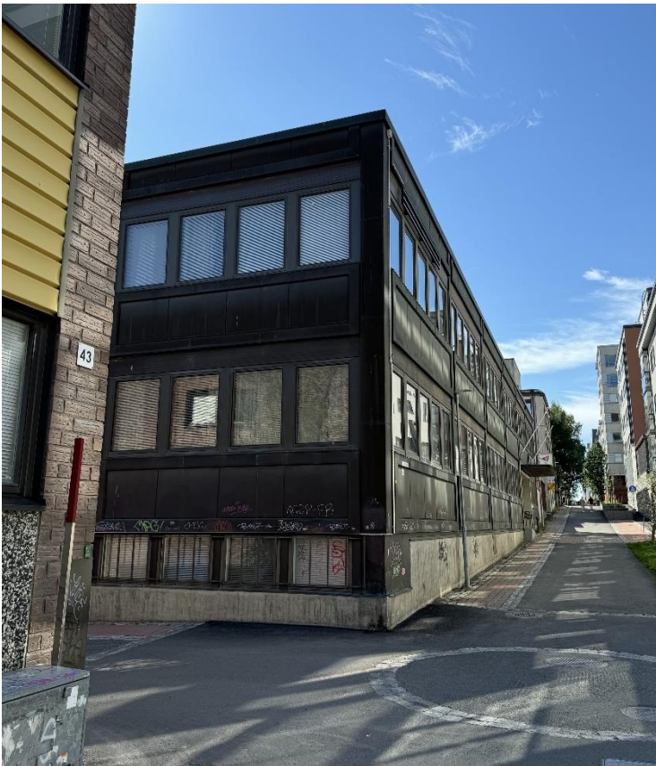
Kuva 6. Oleva vuonna 1974 valmistunut toimistorakennus kuvattuna Käsityökadulta 7/2024
