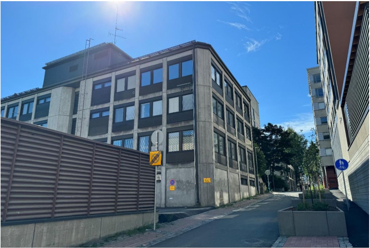
Kuva 5. Oleva vuonna 1982 valmistunut liike- ja toimistorakennus kuvattuna Käsityökadulta 7/2024
