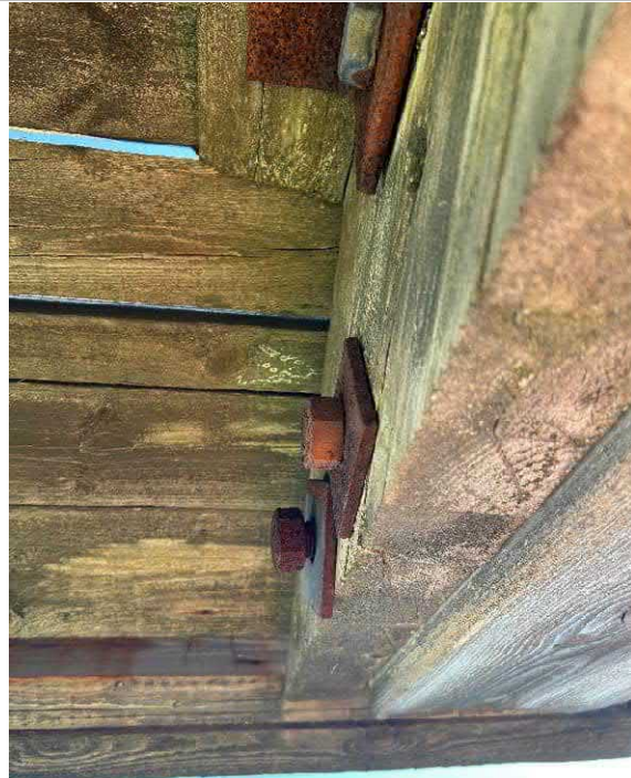
Kuva 22 Pulttiliitoksissa on löysyyttä.
