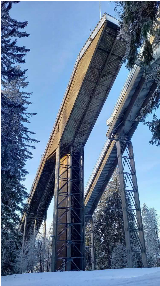
Kuva 1. Yleiskuva K90 vauhtimäestä. Pääkannatinkehä lähimpänä. Välikehä näkyy pääkannatinkehän takana. Teräsbetonipilarit eivät näy kuvassa.
