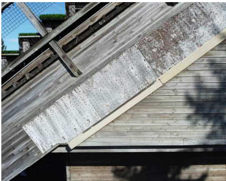
Kuva 7. Liimapuupalkin vanerikorjauksen kunto
