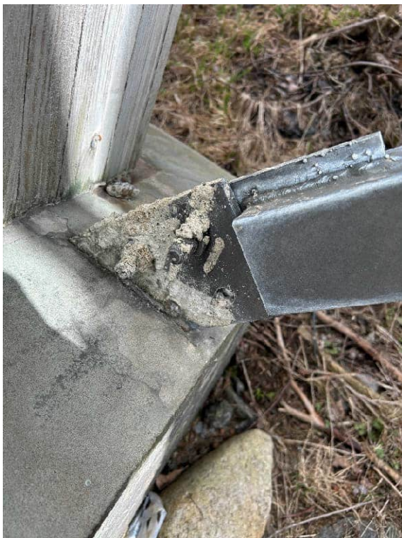
Kuva 11 Liimapuupilarin perustukselta lähtevän siteen alapäästä vain 2/4 reiässä on pulttikiinnike.
