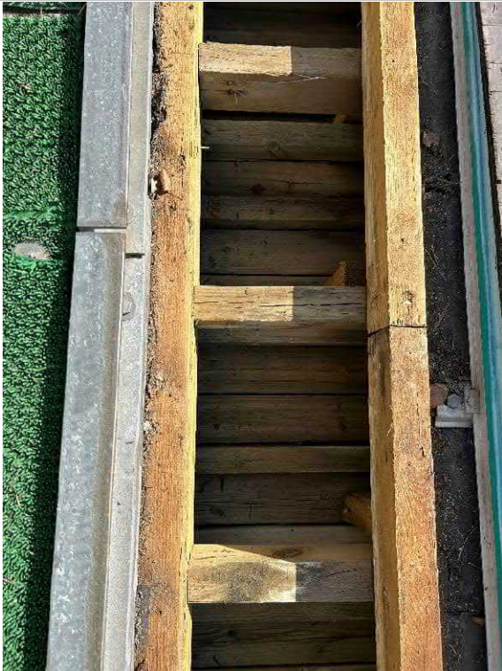
Kuva 30 Puurakenteissa ei havaittu selviä lahovaurioita.
