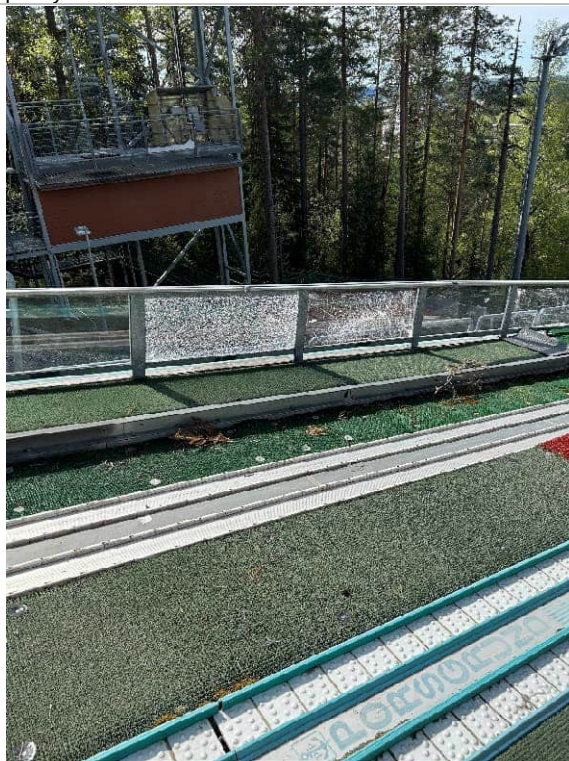
Kuva 33 Yksi mäen plekseistä/laseista on hajennut.
