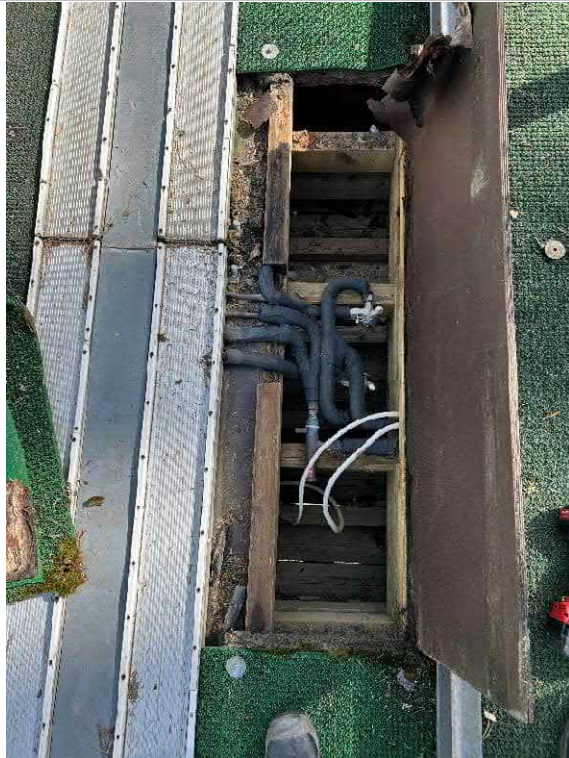
Kuva 31 Avattua rakennetta oikealta puolelta latua edestä katsottuna. Mikroporaus suoritetaan rakenneavauksen päädyistä.
