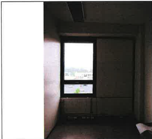
Kuva 1: Toimistohuoneen ulkoseinä ennen sisäpuolista avausta
