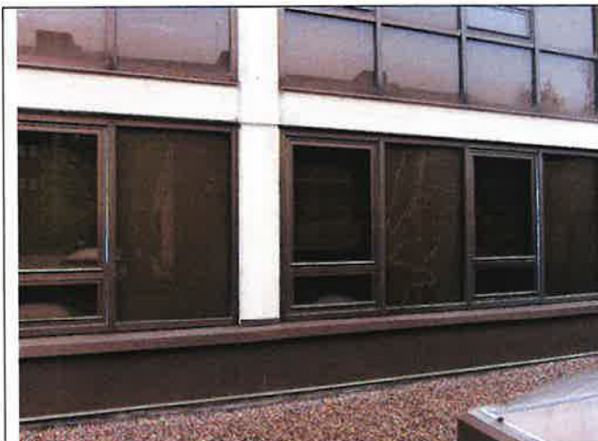
Kuva 23: Julkisivun lasitusta eteläsivustan vesikatolta nähtynä
