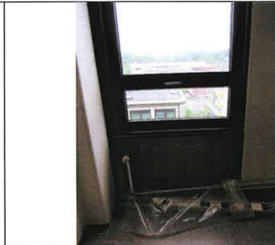
Kuva 2: Ikkunan alapuolelta avattua ulkoseinää
