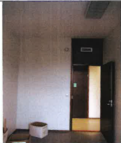
Kuva 22: Tulo- ja poistoveniilien sijainti toimistohuoneessa
