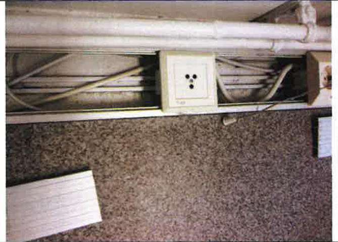
Kuva 20: Koteloinnin sisusta on erittäin vaikeasti siivottavissa
