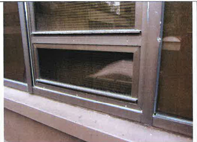
Kuva 24: Tuuletusikkunan liittyminen julkisivun lasirakenteisiin
