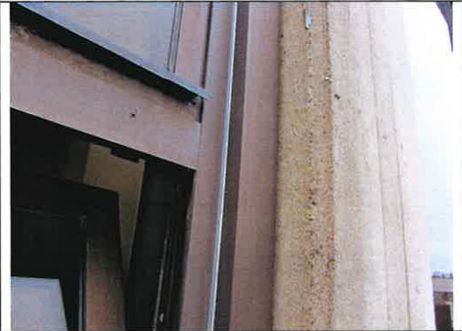
Kuva 18: Tuuletusikkunan yläpuolisia rakenteita ja liittyminen betonipilariin
