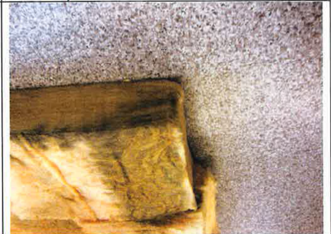
Kuva 10: Nurkissa tummentumat ulottuvat lähes koko eristekerroksen paksuudelle, joh-tuen epätiiviydestä asennuksesta
