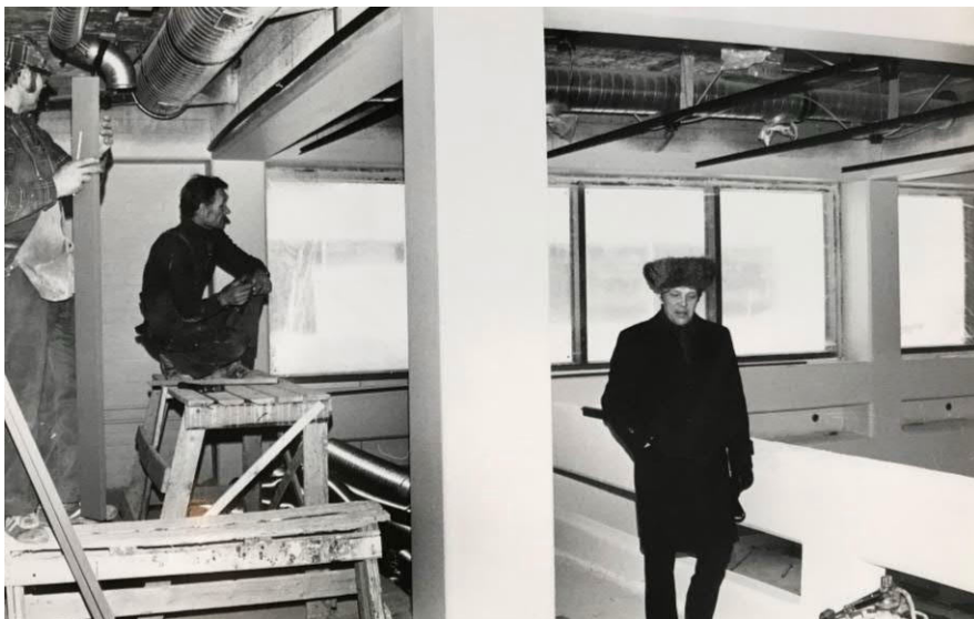
KUVA 7. Keskuseurakuntatalon rakennustyömaa etenee (Kirkko ja Koti 1979)
