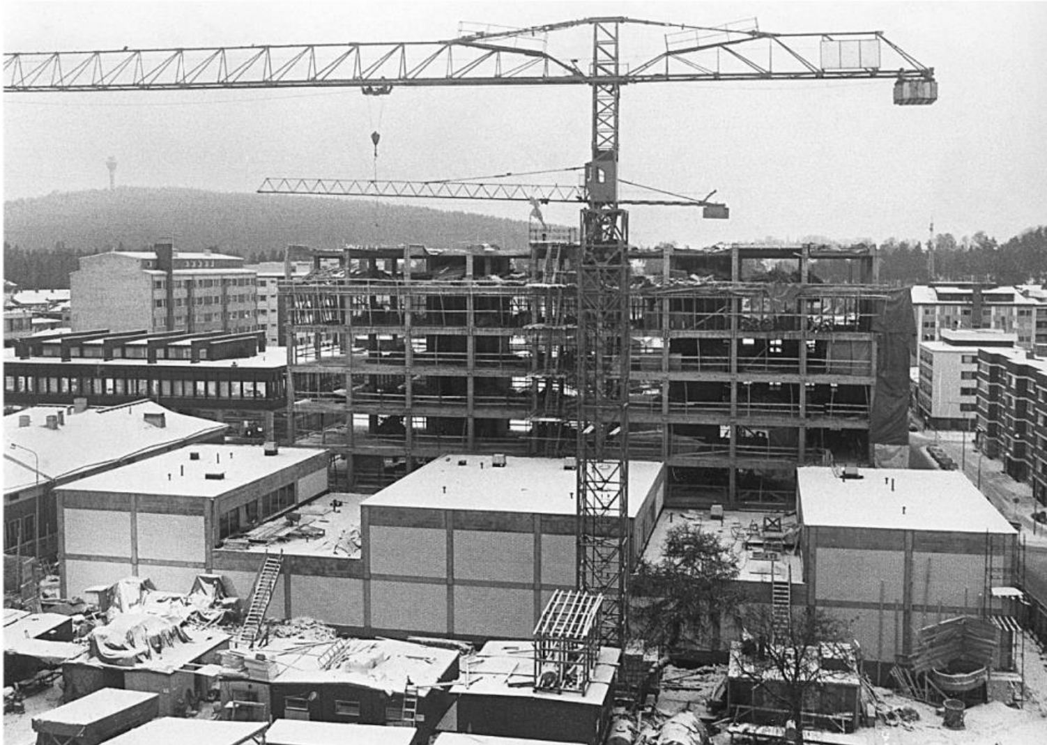
KUVA 44. Rakennustyömaa käynnissä (Kirkko ja koti)
