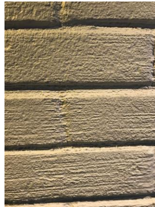
KUVA 68. Puhtaaksi muurattu ja slammattu tiili (Pätynen 01/2019)
