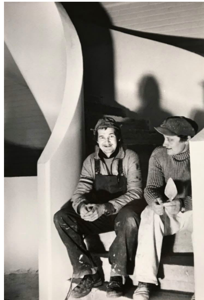
KUVA 9. Rakennustyöläiset työmaalla 23.3.1979 (Kirkko ja Koti 1979)
