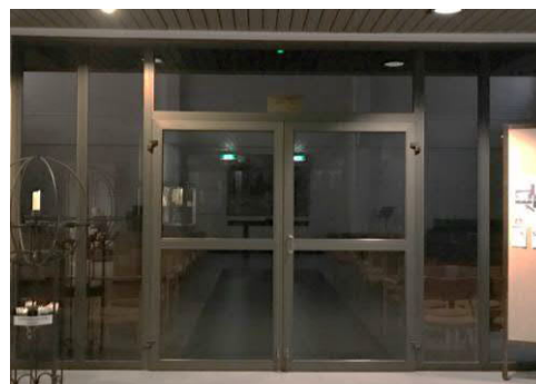
KUVA 74. Metallirakenteinen lasiväliovi seurakuntasaliin (Pätynen 2019)
