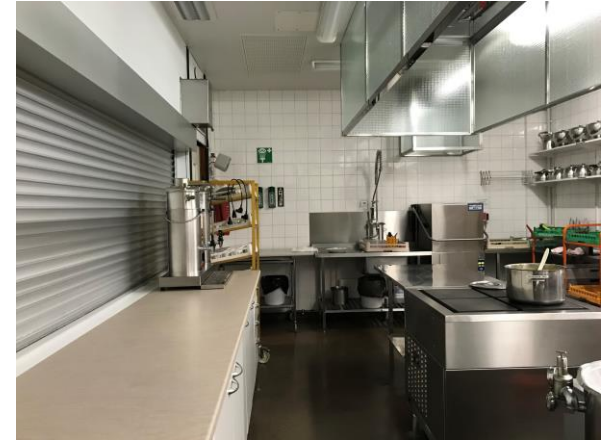
KUVA 63. Valmistuskeittiö 1. kerros (Pätynen 01/2019)
