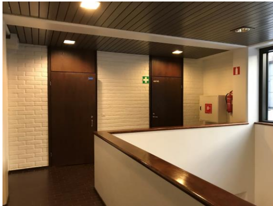
KUVA 67. Lattiapintaa ja katon alumiinipanelointia (Pätynen 01/2019)
