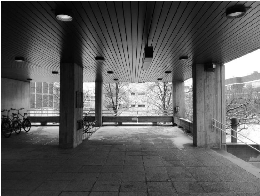
KUVA 50. Pyörien säilytykseen varattu paikka, jossa kaiteina ovat Malmivaaran suunnittelemat betonikaiteet kukkalaatikoin (Soininen 2017)
