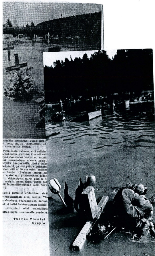
Kuva 7. Isolla hautausmaalla tapahtunut hulevesitulva, jonka vesi tulvi linja-autoaseman kellarikerrokseen vuonna 1973. Savon Sanomat, arkisto.
