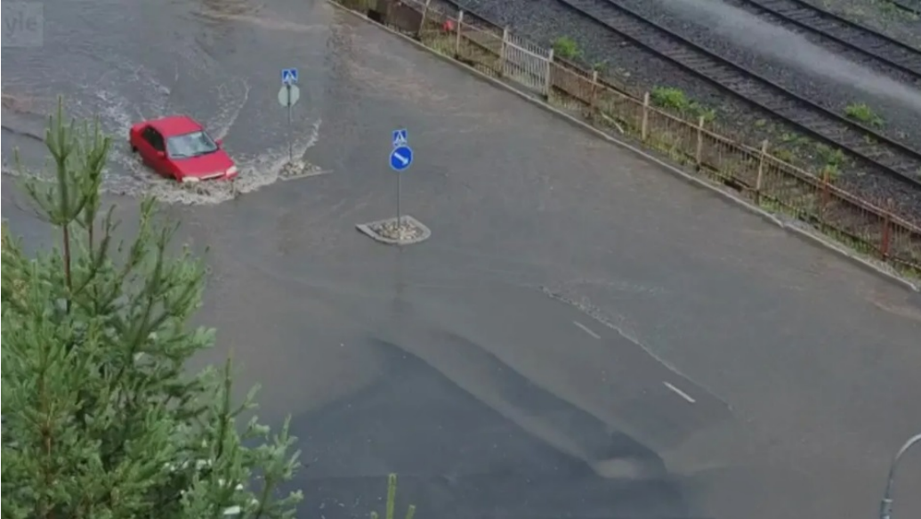
Kuva 9. Pohjolankadun ja Gottlundinkadulla tapahtunut hulevesitulva vuonna 2021. Kuva: YLE
