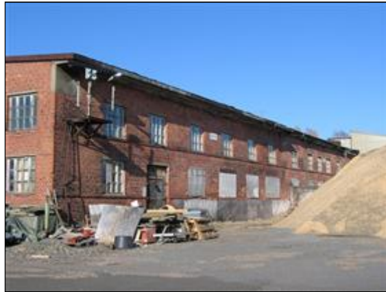
Kuitulevytehtaan itäseinää. (Merja Marin 6.10.2005)
