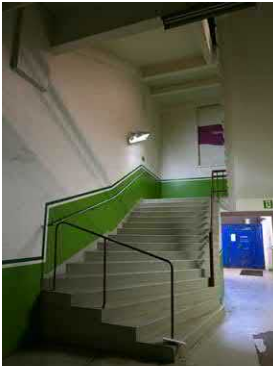
Pääsisäänkäynti ja portaikko. Portaikko on säilynyt suhteellisen alkuperäisenä. Tilan ikkunat on muurattu umpeen. Ensimmäiseltä välitasanteelta ylöspäin on taidokkaasti toteutetut teräsrakenteiset kaiteet, joissa on puiset käsijohteet.
