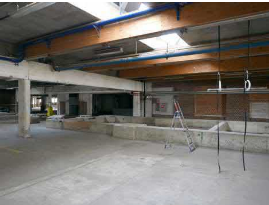
Toisen kerroksen kattoikkuna. Yläpohjan sekundääripalkit ovat liimapuuta.
