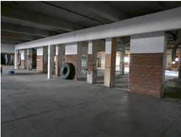
Kuvissa näkyy alkuperäistä tulitikkutehtaan seinärakennetta ja aukkojen umpeen muurauksia. Toisen kerroksen kattoikkuna sijaitsee vuoden 1964 laajennusosassa, joka on aivan tulitikkutehtaan kyljessä.
