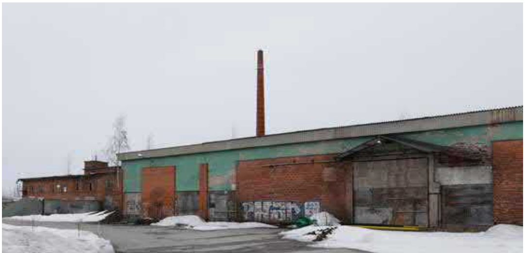
Kuvassa oikealla vuonna 1959 valmistunut arkkitehti Kaj Michaelin suunnittelema karkaisuosasto. Kuvassa vasemmalla vuonna 1969 valmistunut Lauri Itkosen suunnittelema laajennus (kaksi vasemman puolesita ovea), joka noudattelee vuoden 1959 osan tyyliä.
