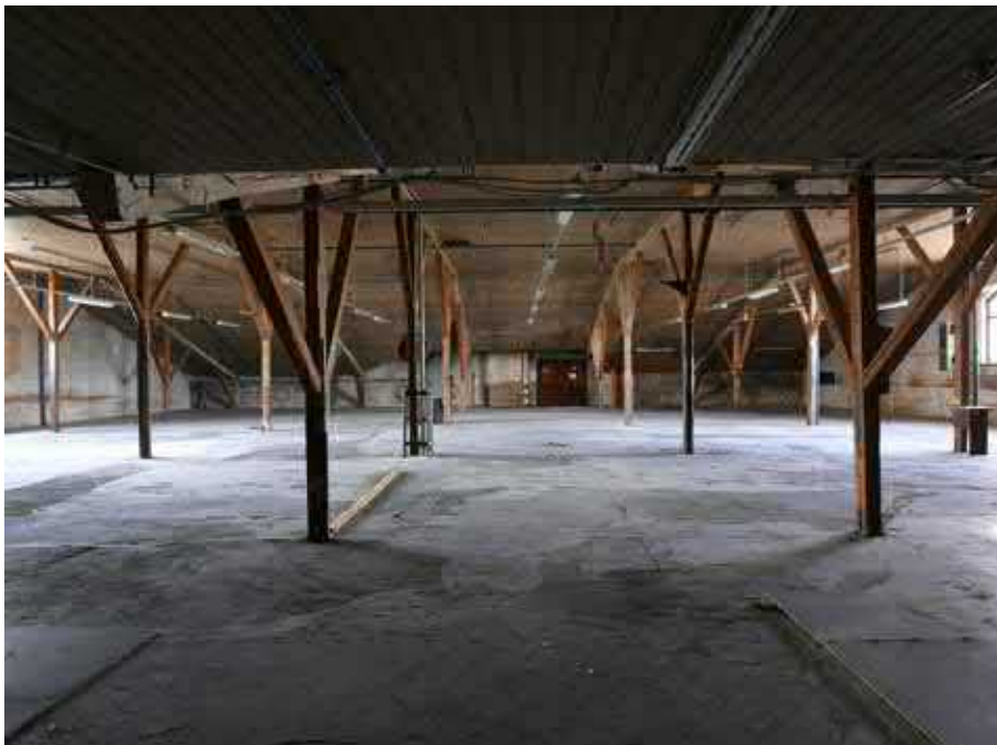
Keskiosan korkea ullakkotila, jossa on edelleen alkuperäiset puiset kannatinrakenteet. Tilassa on ollut teollisuuden liittyvää toimintaa. Tilassa on edelleen poikkipäädyn alkuperäiset yläikkunat. Lattia on betonia
