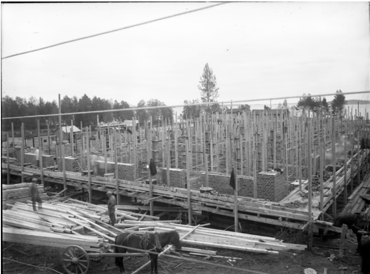
Kuva tulitikkutehtaan rakennustyömaalta vuonna 1922. KUHMU.
