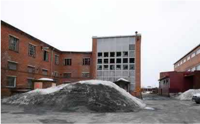
Pitkänomaiseen tehdasrakennukseen tehtiin laajennus vuonna 1947 eteläpätyyn (matala L-siipi) sekä vuonna 1958 korkeampi lasiseinäinen laajennus. Viimeisin laajennus erottuu massaltaan selkeänä osana aiemmin rakennetuista osista. Alakuvassa rakennuksen eteläpääty, jossa näkyy myös vuonna 1943 valmistunut matalampi osa.
