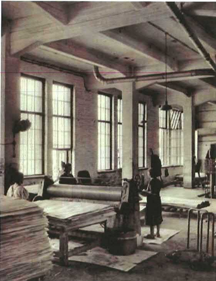
Kuitulevytehtaan ensimmäinen rakennusvaihe alkoi 1942. Ylhäällä ensimmäisen rakennusvaiheen sijainti. Vasemmalla Eino Mäkisen kuva tehtaan sisältä 1940-lopulta tai 1950-luvun alusta. Oikealla alhaalla Sirkka Hyvärisen asemapiirustus vuodelta 1942. Piirustus Kuopion kaupunginarkisto.
