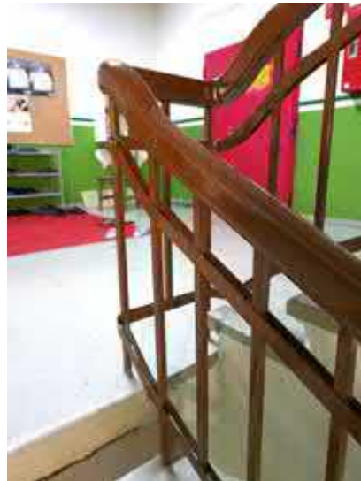
Pääsisäänkäynti ja portaikko. Portaikko on säilynyt suhteellisen alkuperäisenä. Tilan ikkunat on muurattu umpeen. Ensimmäiseltä välitasanteelta ylöspäin on taidokkaasti toteutetut teräsrakenteiset kaiteet, joissa on puiset käsijohteet.
