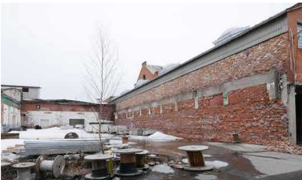
Kuvan oikealla näkyy vanerivaraston laajennus ja rakennusten väliin tehty tunneli vuodelta 1968. Kuvan etualalta on purettu pienimittojen sahausosasto, josta on muistumana rakenteiden osia säilyneissä seinissä.
