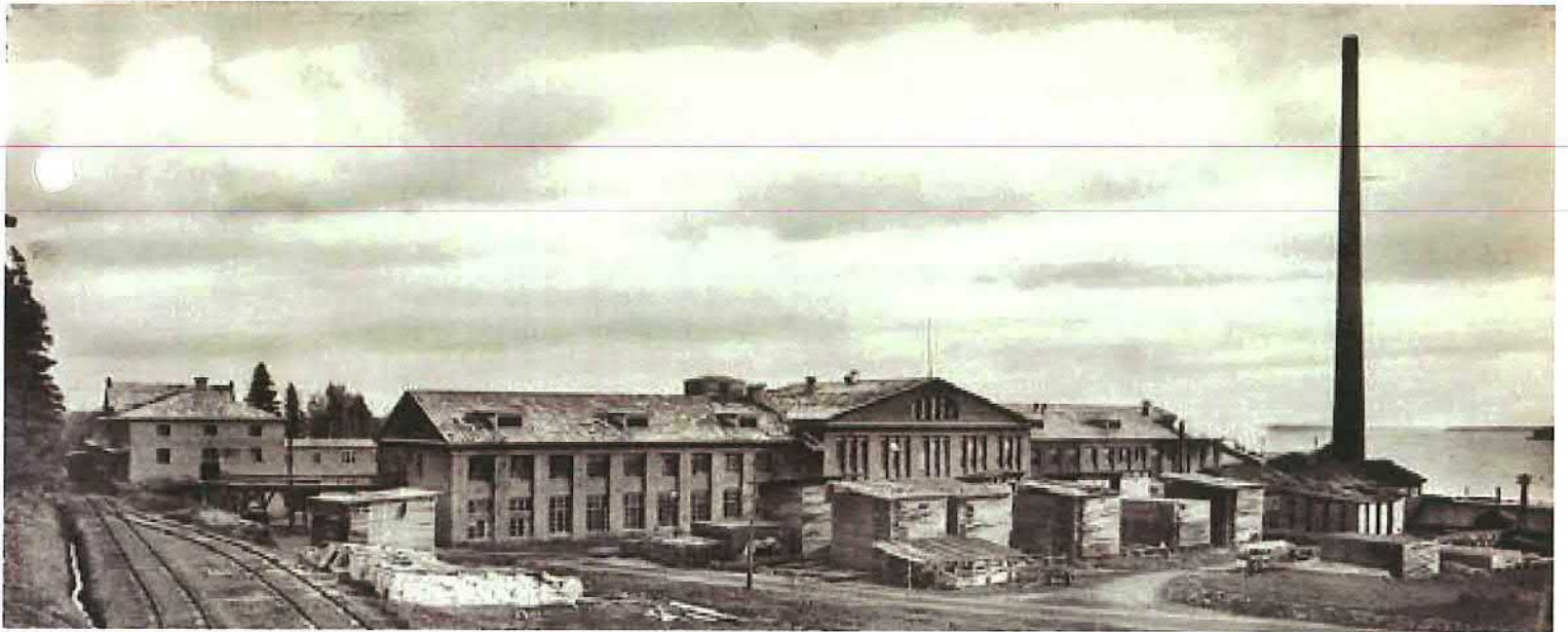
Tulitikkutehdas vaneritehtaana 1940-luvulla ennen suuria laajennusvaiheita. Vasemmalla keskusvarasto ja vuonna 1924 rakennettu Itkonniemen pistoraide. Pihamaan toisella puolen näkyy jo osa uutta kuitilevytehdasta. Kuva Eino Mäkinen teoksesta Kuopio Kallaveden kaupunki, 1958.
