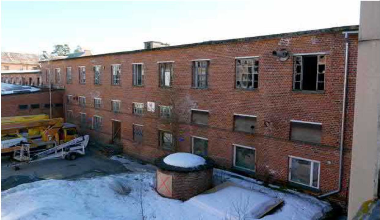
Alkuperäinen vuonna 1942 valmistunut osa oli 1 kerroksinen. Alin ja keskimäinen ikkunarivi ovat vanhimman osan ikkunoita ja ylin rivi vuoden 1947 korotusta.
