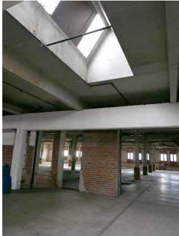
Kuvissa näkyy alkuperäistä tulitikkutehtaan seinärakennetta ja aukkojen umpeen muurauksia. Toisen kerroksen kattoikkuna sijaitsee vuoden 1964 laajennusosassa, joka on aivan tulitikkutehtaan kyljessä.
