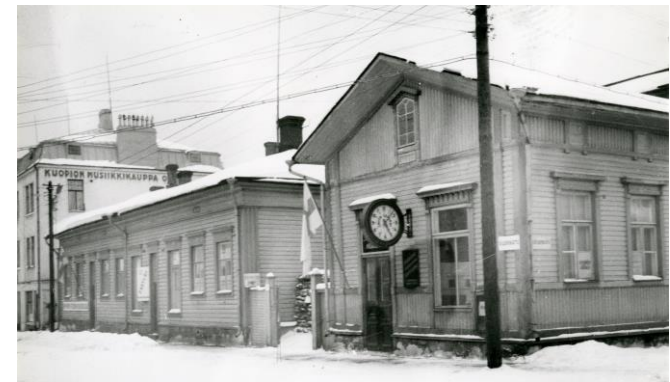
Kirjapainon paikalla olleet puutalot purettiin rakennuksen alta 1956.
