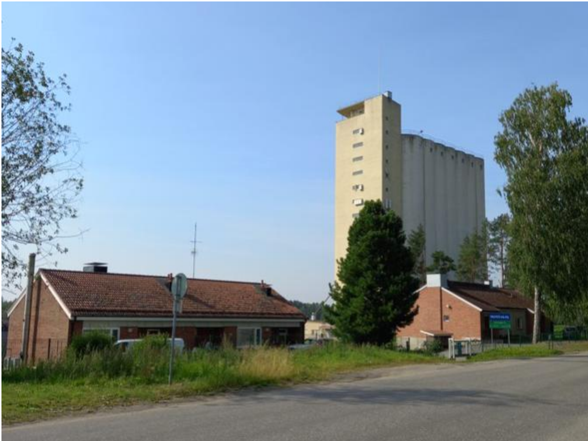
Kuva 10. Viljasiilo ja asuinrakennukset Tehdaskatu 26 B ja A.
