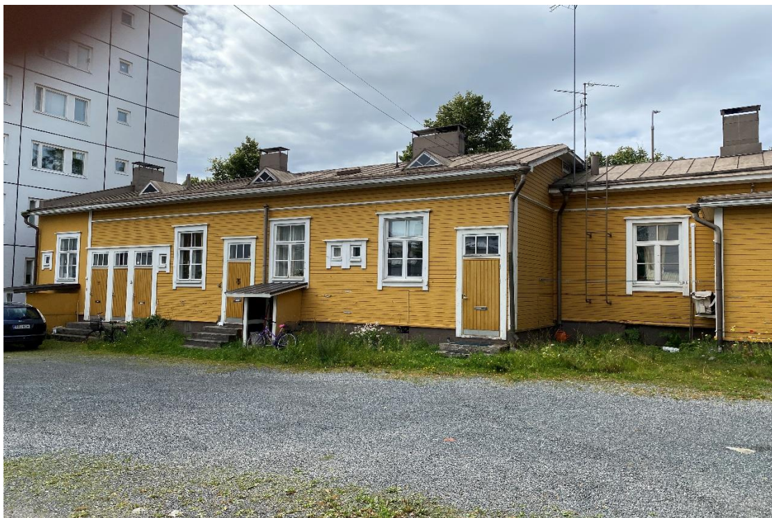
Kuva 32. Kuvassa kohtuullisen hyväkuntoista laajennusosan julkisivua sisäpihan puolelta.
