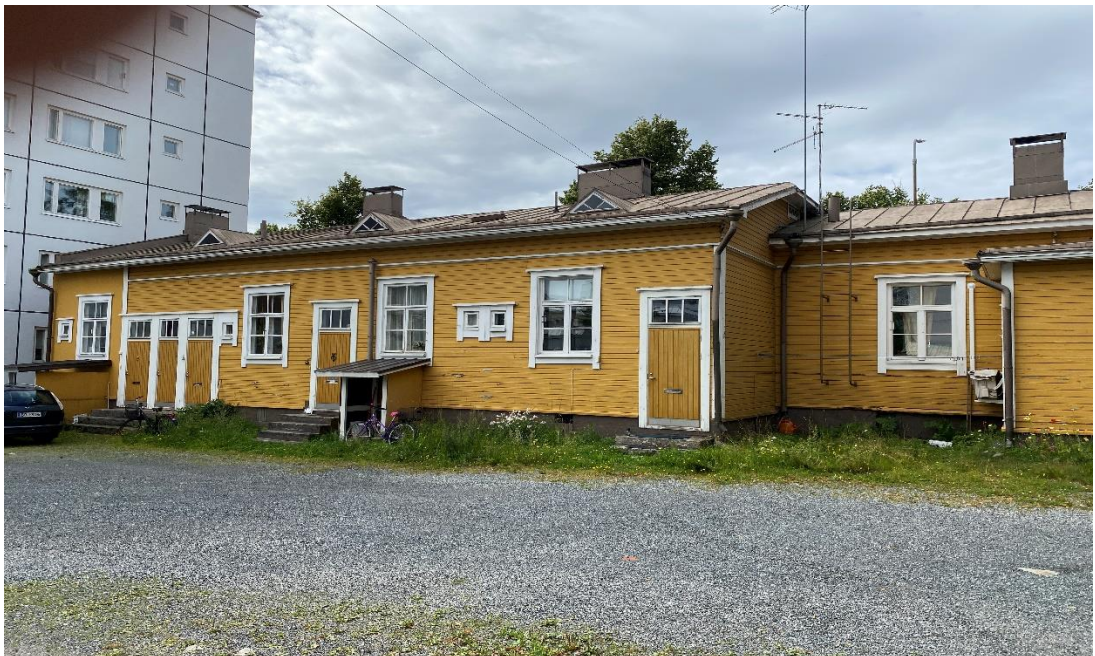
Kuva 24. Kuvassa julkisivua sisäpihan puolelta.
