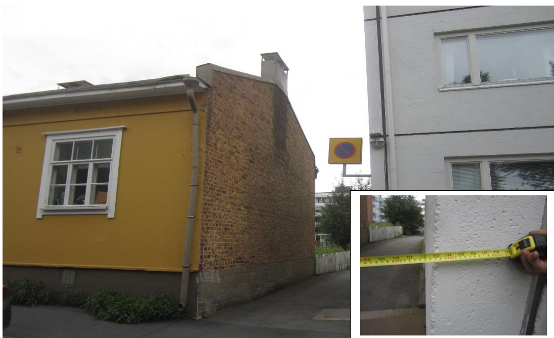
Kuva 31. Kuvassa kivrakenteisen osan kohtuullisen hyväkuntoista julkisivua. Tällä kohtaa rakennusten väli on n. 290 cm, joten jos puutalon päädyn savuhormia käytetään, niin sen käyttöturvallisuus suositellaan varmistettavaksi paloviranomaiselta.
