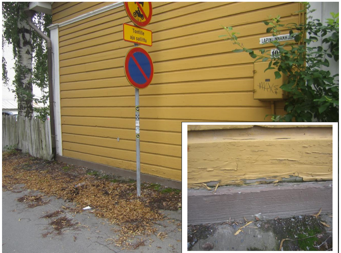
Kuva 25. Rakenneavaus kohdistettiin alkuperäisosan päätyyn, pienessä kuvassa näkyvään lahovaurioituneeseen kohtaan.
