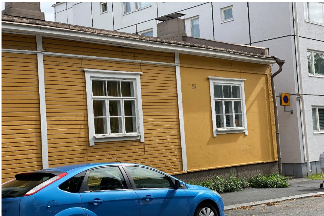
Kuva 30. Kuvassa laajennusosan julkisivua sairaalakadun puolelta.
