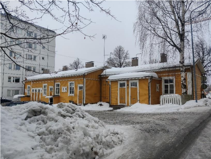
Kuva 3. Oleva puinen rivitalo, oikea pääty on vanhin 1800-luvun lopulla rakennettu osa 3/2024
