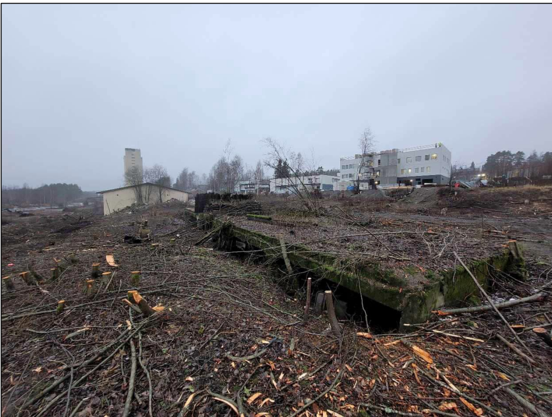
Kuva 2. Vanhan puretun rakennuksen rakenteita kiinteistön keskiosassa. Taustalla kuvan vasemmassa reunassa kiinteistön länsireunalla sijaitseva varastorakennus.
