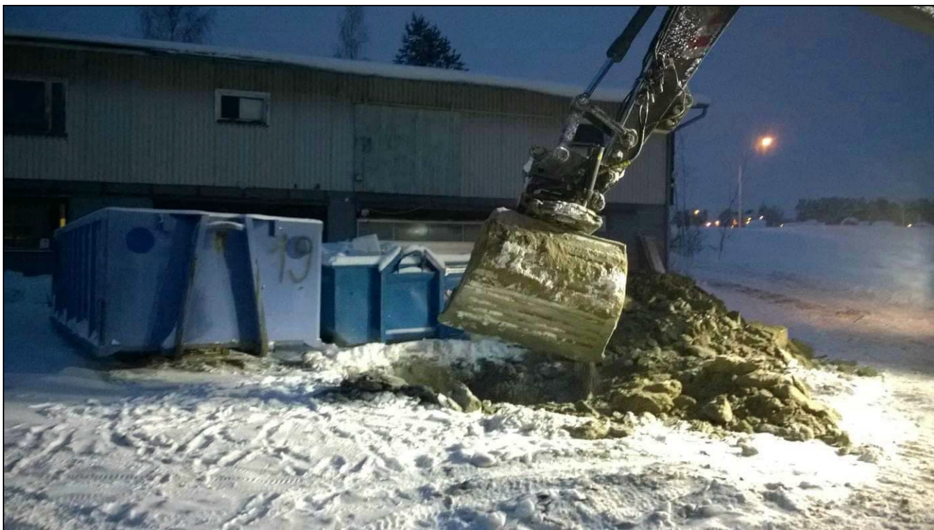
Kuva 6. Kuvassa koekuopan KK9 kaivamista. Kuva otettu etelän suunnasta.
