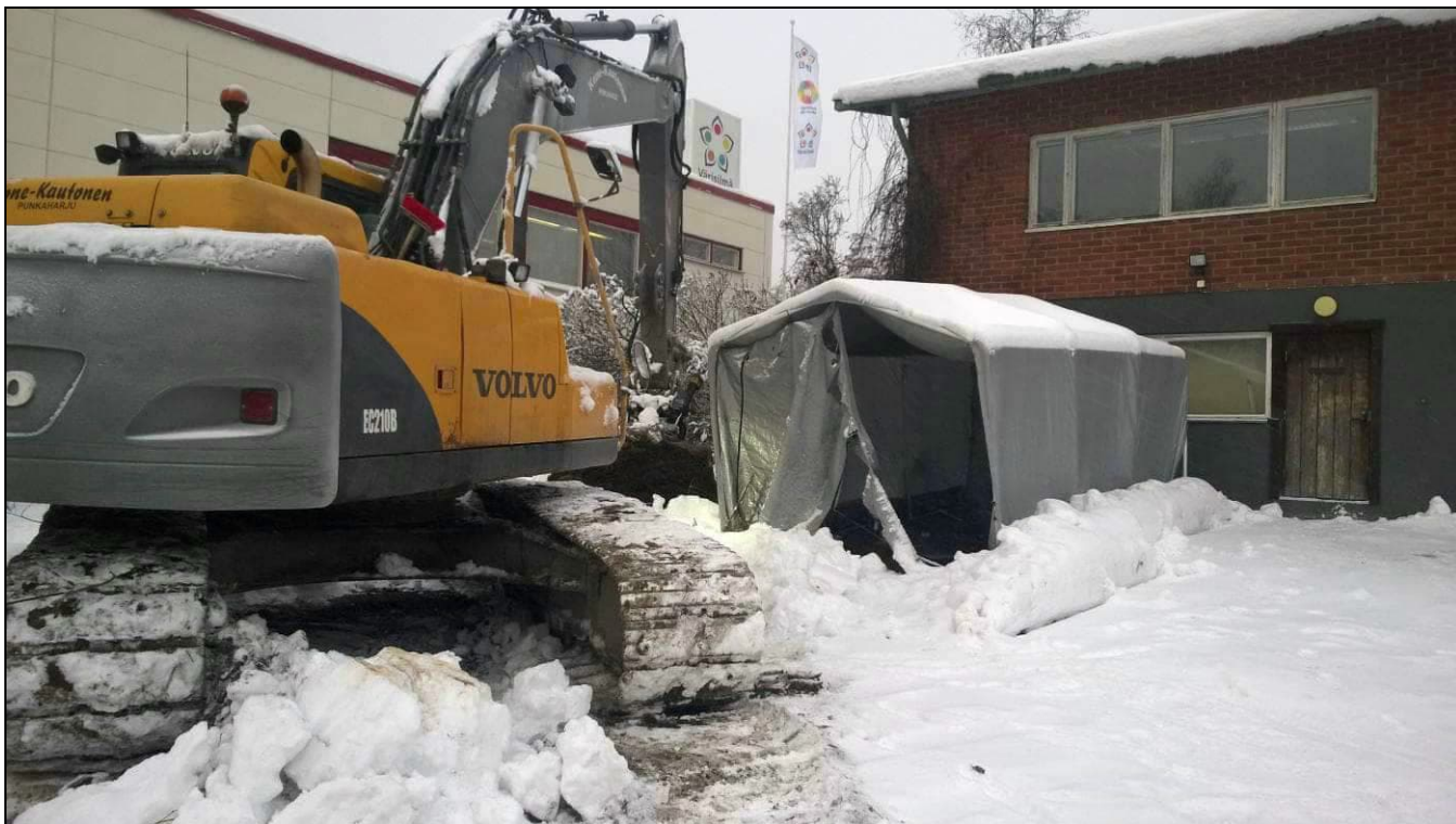
Kuva 3. KK5 sijoittui purettavan rakennuksen lounaisnurkan edustalle. Kuva on otettu kaakosta.
