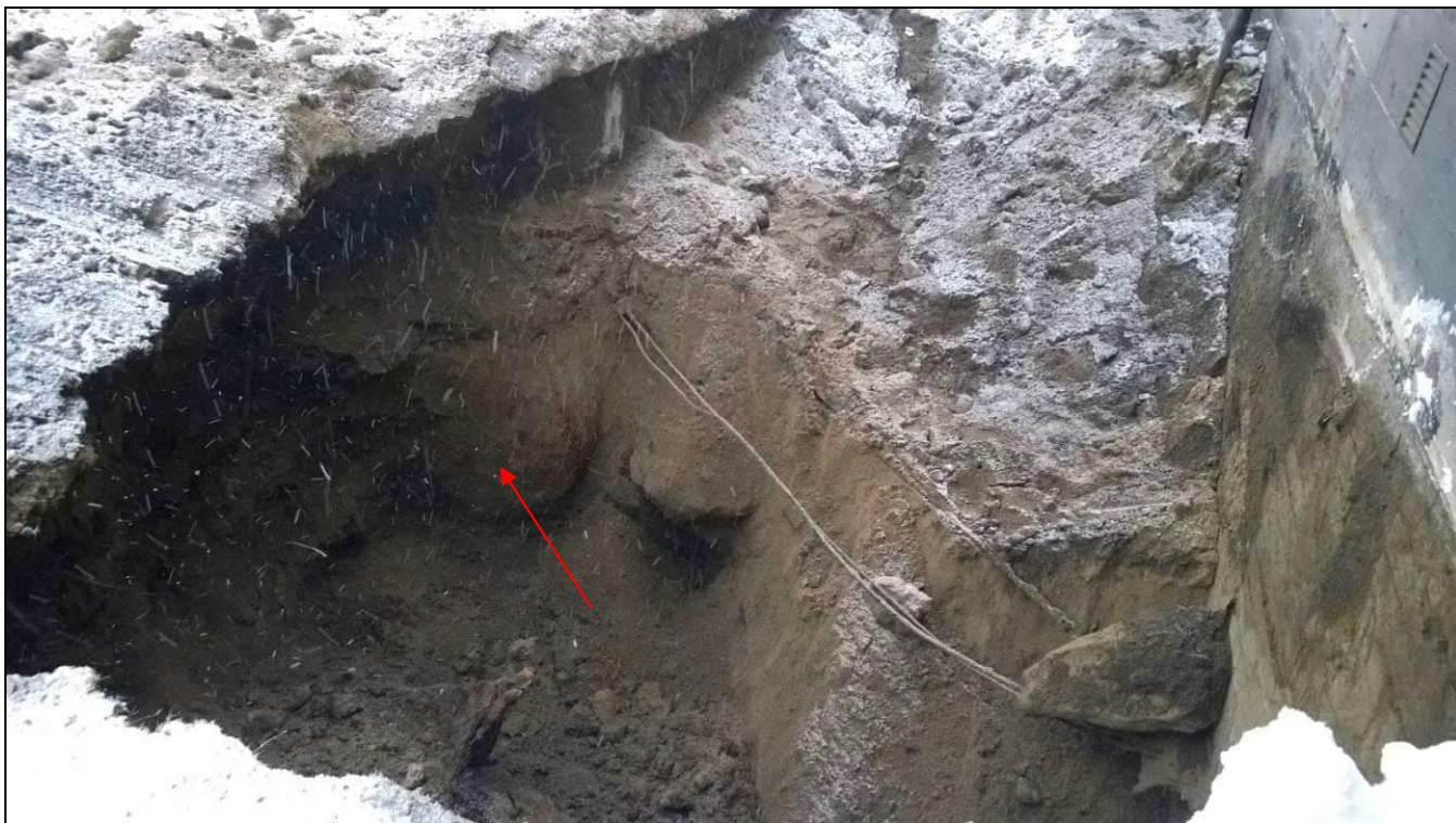
Kuva 5. Säiliön alapuolisessa maaperästä otetussa maanäytteessä ei todettu öljyhiilivetyjen aiheuttamaa pilaantumista. Kuvassa säiliön pääty on osoitettu punaisella nuolella.
