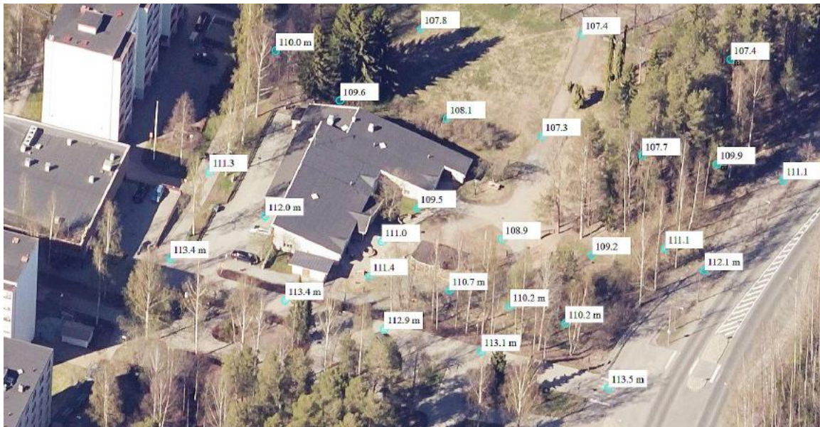
Kuva 19. Saarikellon päiväkodin tontin korkeusarvoja. Kuvassa näkyvä vanha päiväkotirakennus on purettu.
