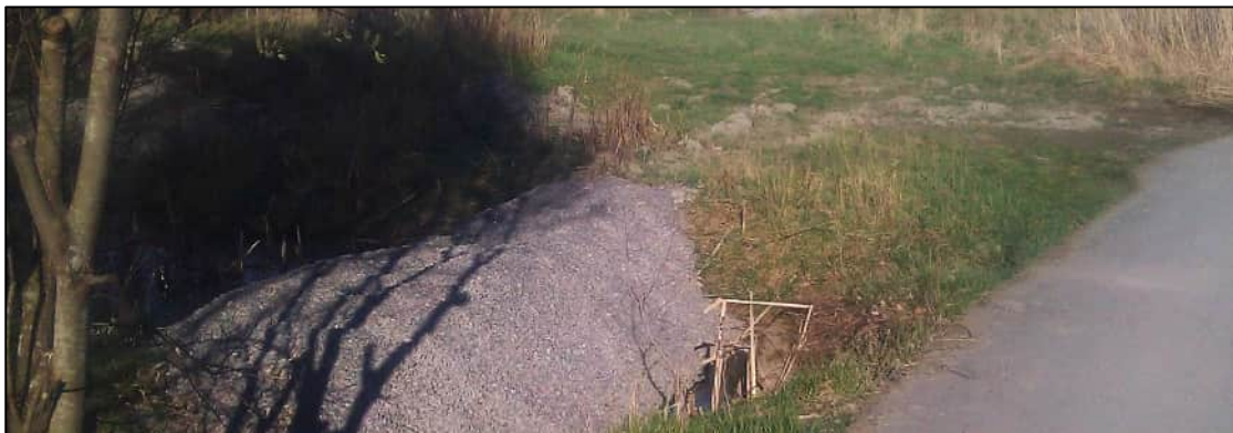
Kuva 19. Avo-ojan eteen rakennettu väliaikainen suodattava murskepato. Turku, Haarlahti. 16
