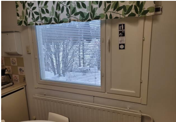
Kuva 6. Päiväkodin ikkunat ja ulko-ovat ovat hyväkuntoiset, ne on uusittu edellisten korjausten yhteydessä
