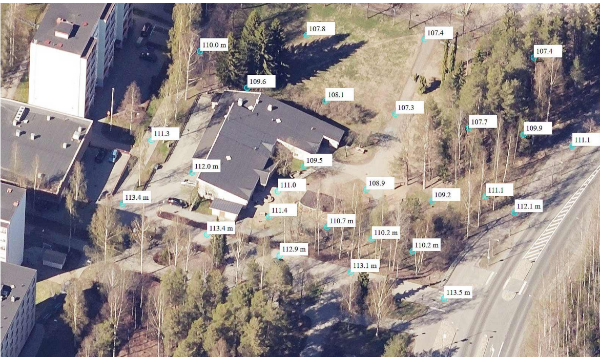
Kuva 3. Päiväkodin tontin korkeusarvoja. Kuvassa jo purettu vanha päiväkotirakennus.
