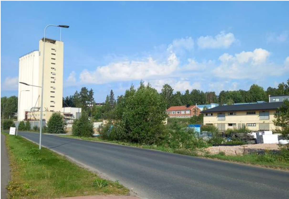
Kuva 15. Vanha viljasiilo. Taustalla punatiilinen asuintalo, oikeassa reunassa yksi tasovarastoista.
