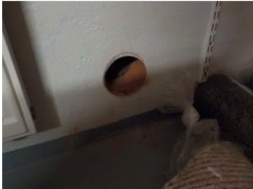
Kuva 5.2.3.5 Varaston avauksen sijainti
