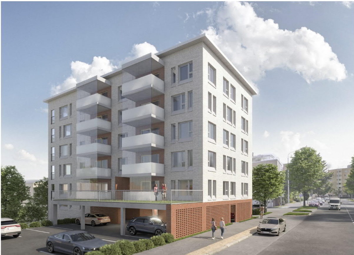
Kuva 18. Haapaniementie 10 VE1 (Arkkitehtipalvelu Oy)
