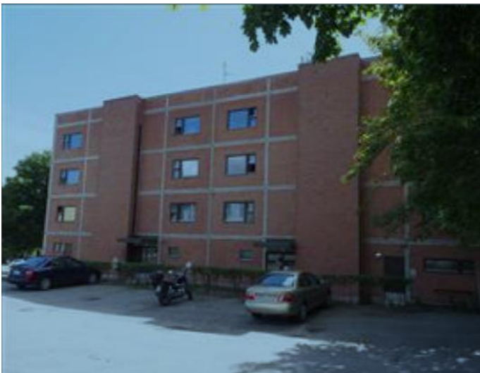
Kuva 6. B-rakennus (Kuva Katri Nousiainen 15.7.2020)
