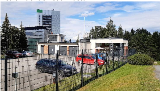
Hälytyskeskus. Takana näkyy MicroTower.
