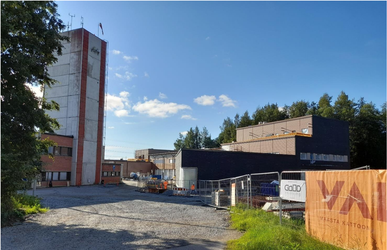
Kuva 6. Uuden pelastusaseman rakennustyömaa elokuussa 2023 (Kuva: Anne Partanen 8/2023)
