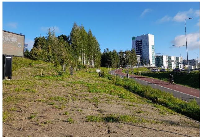
Näkymä Savilahdentien katualueesta kesällä 2023 saneerauksen valmistuttua
