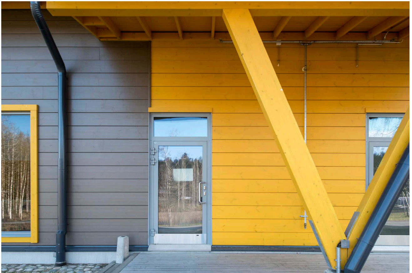
Kuva 6. Nykyisen koulurakennuksen väri- ja muotokieltä. Julkisivuissa on käytetty lamellihirttä, hirsipaneelia ja lomalaudoitusta. Käytetyt värit ovat ruskeanharmaa NCS S 6005-Y20R ja keltainen NCS S 1080-Y20R.
