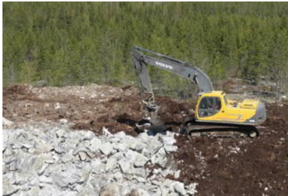
Kuva 5.10 Tuulivoimapaiston rakentaminen alkaa huoltoteiden ja pystytysalueiden rakentamisella (FCG Finnish Consulting Group Oy).
