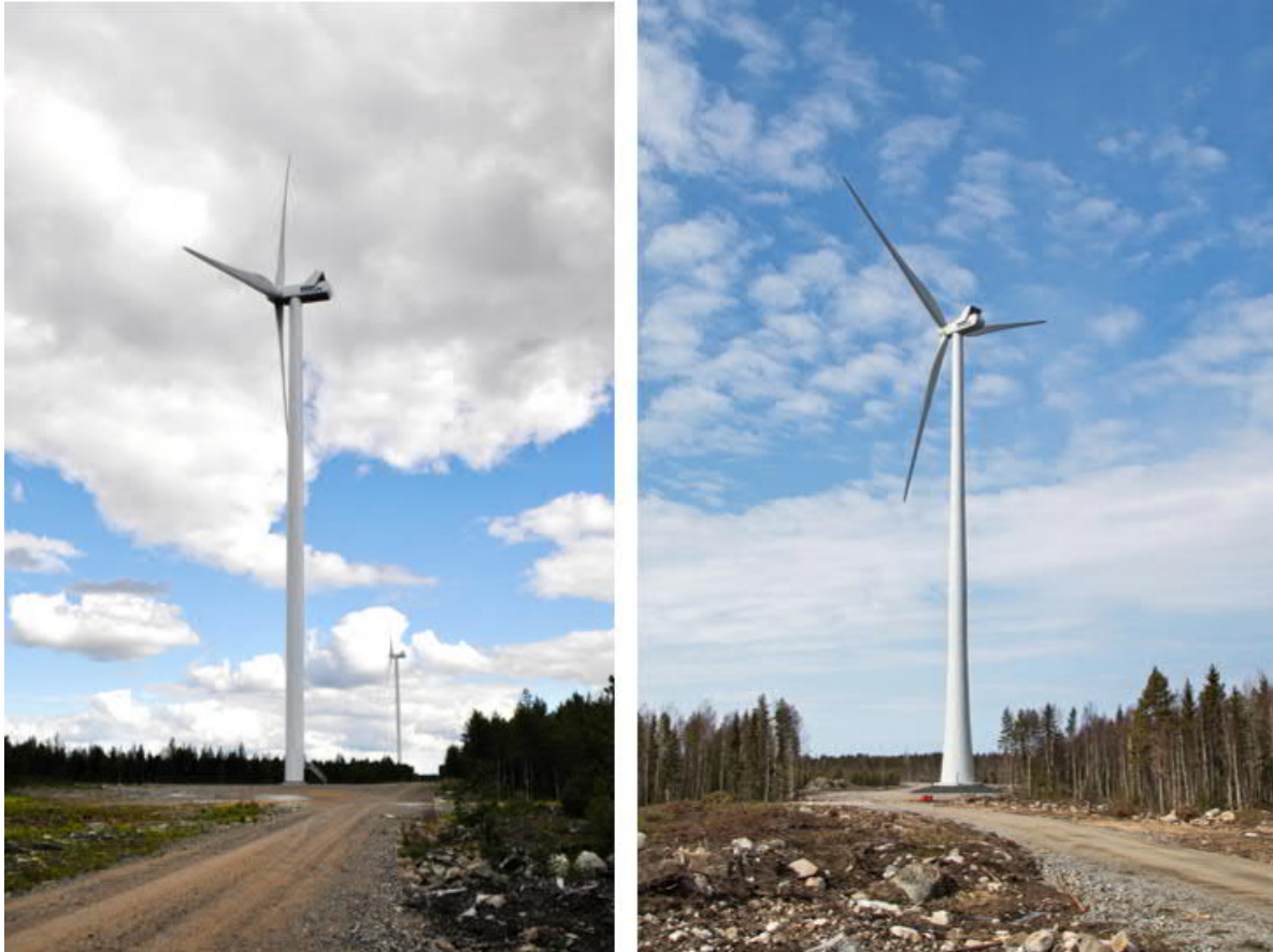
Kuva 5.2 Vasemmalla on esimerkki teräslieriötornista ja oikealla hybriditornista (FCG Finnish Consulting Group Oy).
