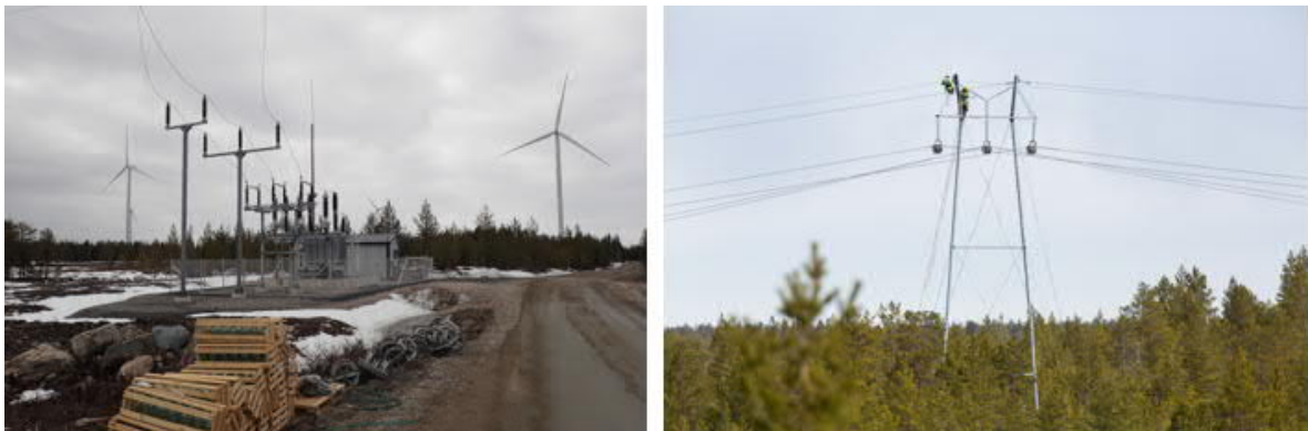
Kuva 5.15 Sähköaseman ja voimajohdon rakentamista (FCG Finnish Consulting Group Oy).
