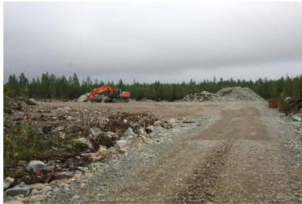
Kuva 5.10 Tuulivoimapaiston rakentaminen alkaa huoltoteiden ja pystytysalueiden rakentamisella (FCG Finnish Consulting Group Oy).
