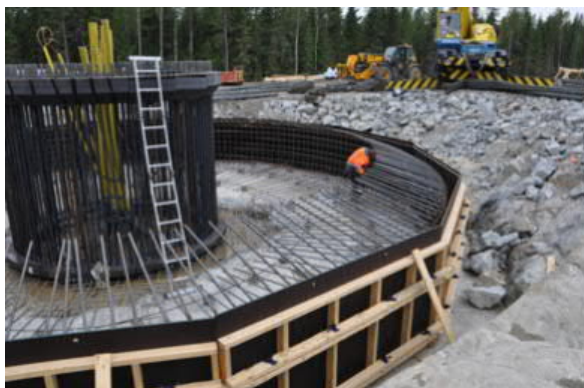
Kuva 5.12 Tuulivoimalan perustusten rakentamista (FCG Finnish Consulting Group Oy).
