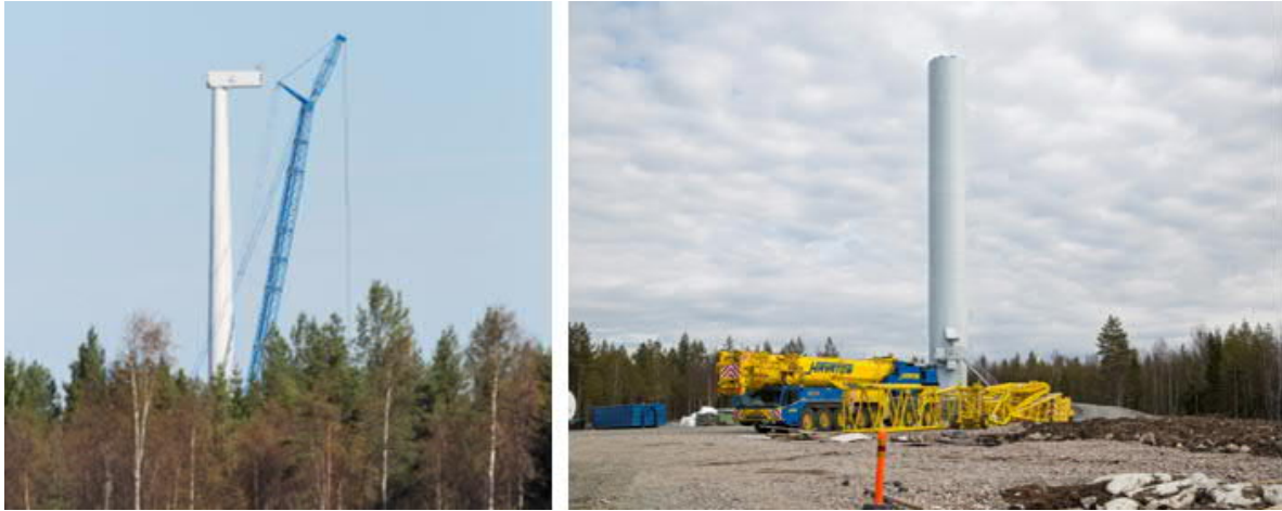
Kuva 5.13 Tuulivoimalan kokoamista (FCG Finnish Consulting Group Oy).
