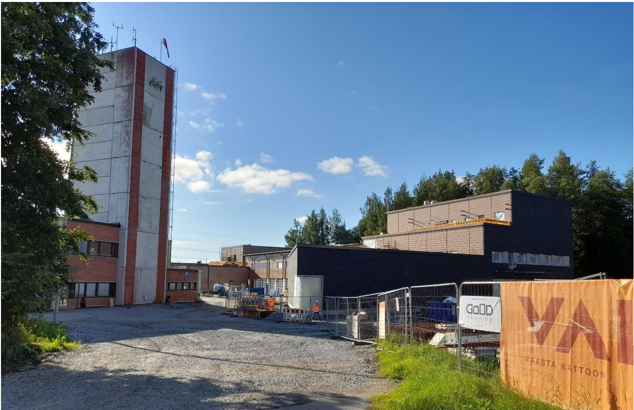
Kuva 6. Uuden pelastusaseman rakennustyömaa elokuussa 2023 (Kuva: Anne Partanen 8/2023)
