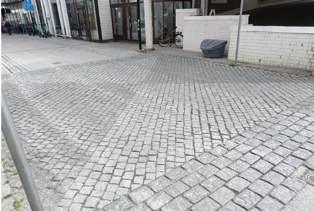
Kuva 14. Luonnonkivellä toteutettu kulkuväylä Lapinlinnankadulla.
