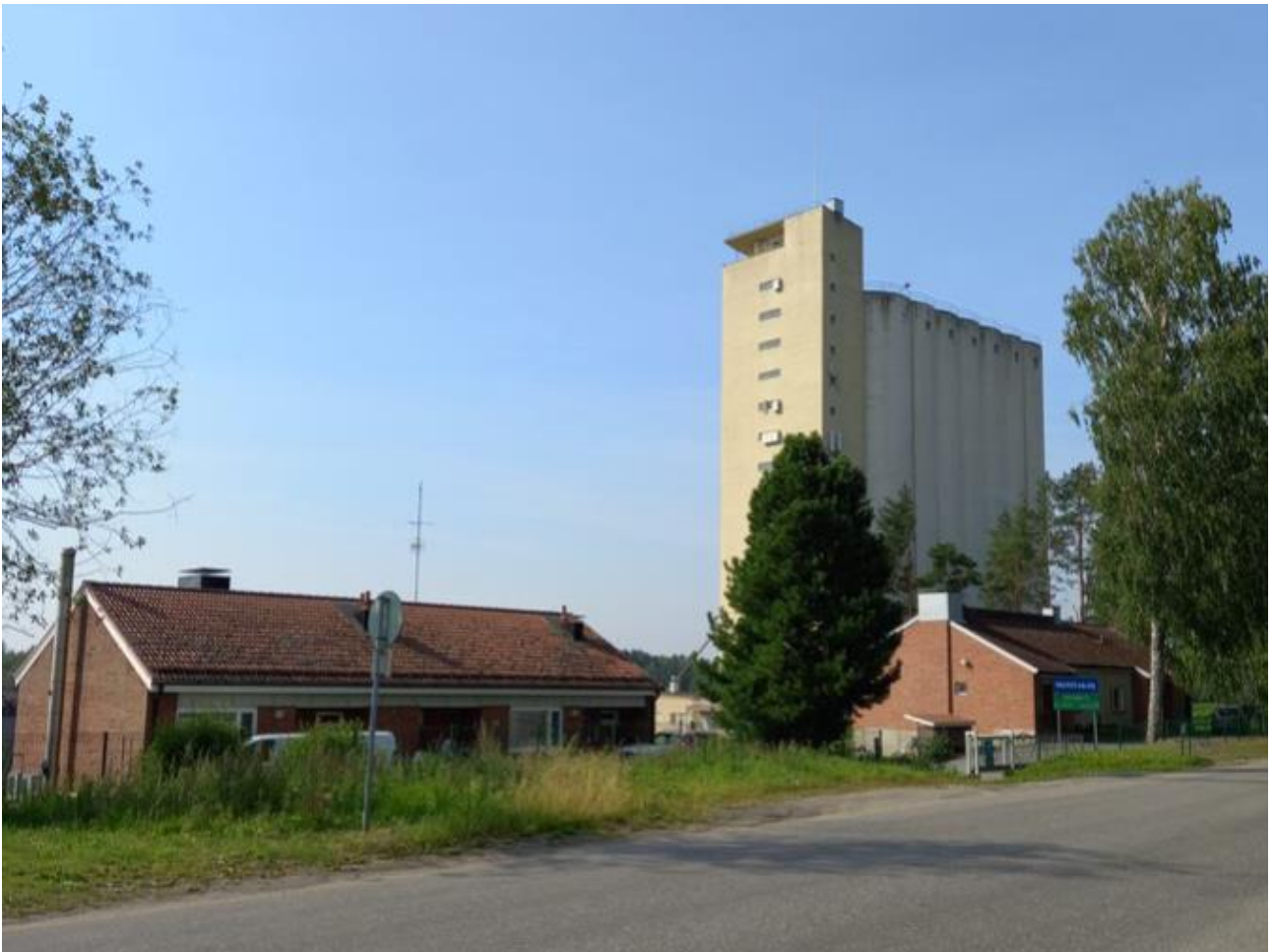
Kuva 10. Viljasiilo ja asuinrakennukset Tehdaskatu 26 B ja A.
