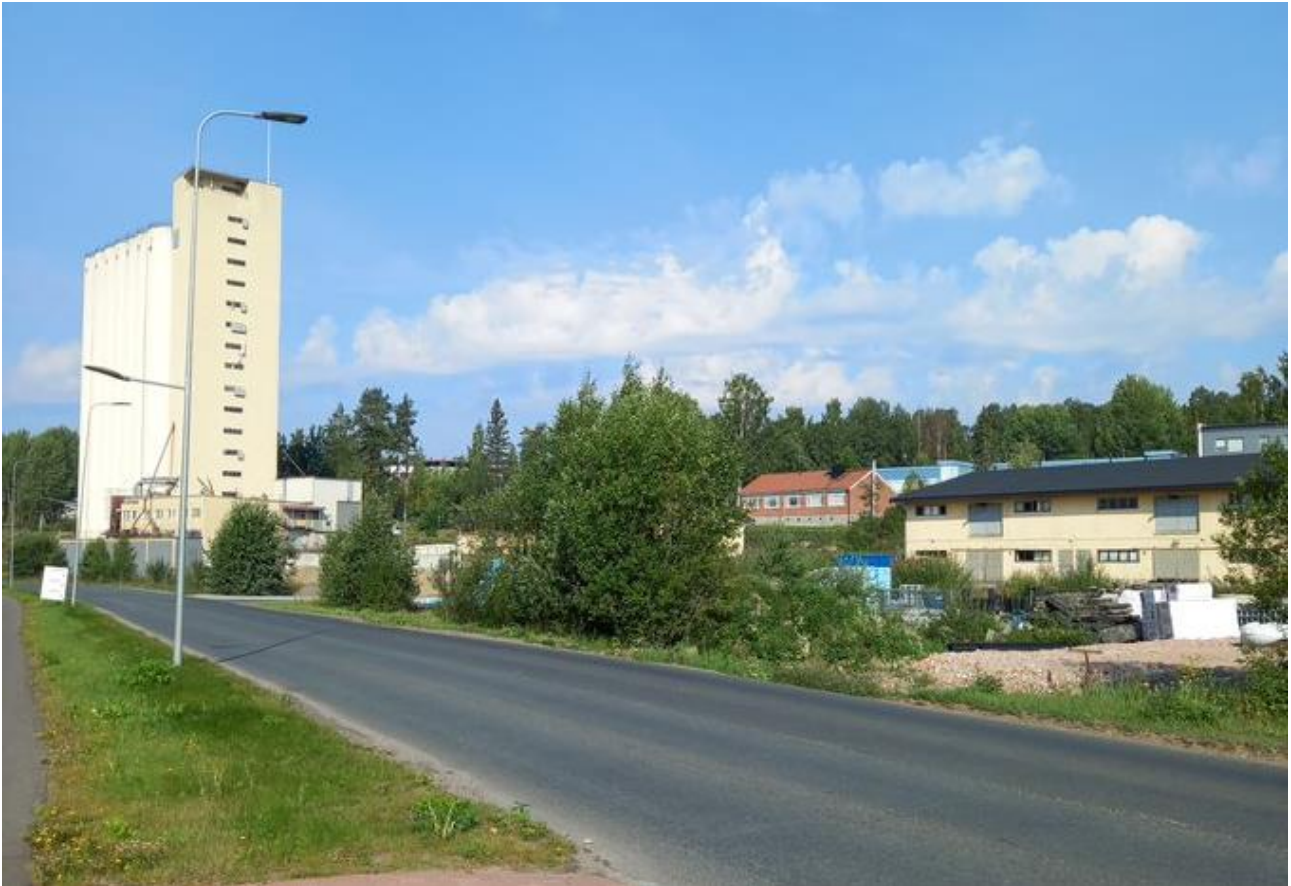
Kuva 15. Vanha viljasiilo. Taustalla punatiilinen asuintalo, oikeassa reunassa yksi tasovarastoista.
