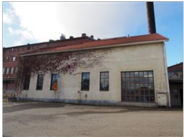
Kuva 14 Lämpökeskus, valokuva 2020 Aada Mustonen.
