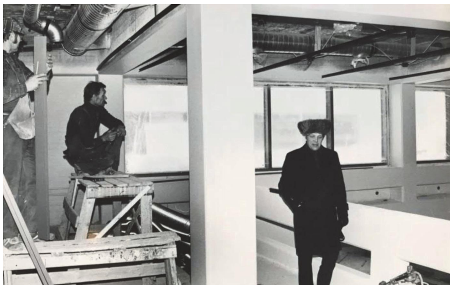
KUVA 7. Keskuseurakuntatalon rakennustyömaa etenee (Kirkko ja Koti 1979)
