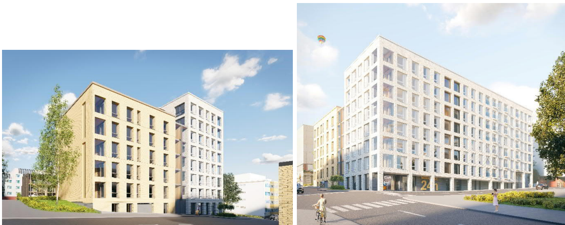
Kuva 41. Näkymä Vuorikadulta sekä Suokadun ja Vuorikadun kulmasta. Kuva: UKI Arkkitehdit.
