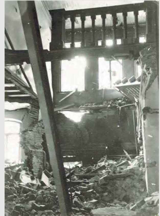
Talvisodan pommitukset vaurioittivat myös sokeainkoulua. Koulun alueelle pudotettiin 5.3.1940 pommeja, joista yksi tuhosi koulurakennuksen pääportaan ja siihen liittyvät ensimmäisen kerroksen muuratut seinät sekä romahdutti osan toisen kerroksen käytävän puurakenteisesta lattiasta. Kuvat on otettu keskikäytävältä lounaaseen (vasemmalla) ja länteen (oikealla). Kuvat: Kuopion kulttuurihistoriallinen museo
