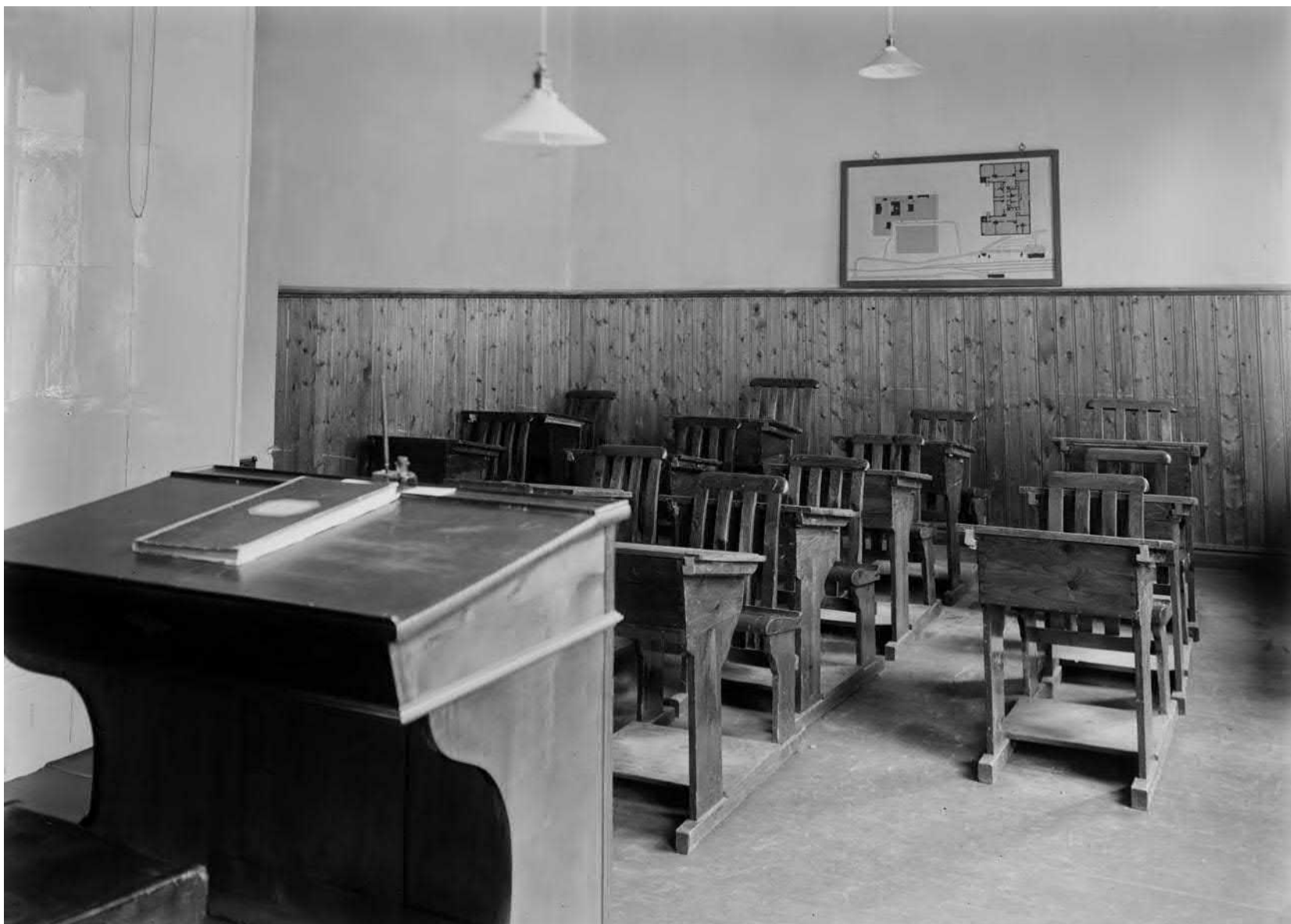
Koulurakennuksen toisen kerroksen luokkahuone vuonna 1913. Sama luokkahuone näkyy myös vuonna 1902 otetussa kuvassa (sivu 9), jossa kalusteet ovat erilaisessa järjestyksessä. Takaseinällä rintapanelin yläpuolella olevassa kohokuvataulussa on koulun asemapiirros ja internaattirakennuksen pohjakaava. Kuva: Viktor Barsolevitsch, Kuopion kulttuurihistoriallinen museo
