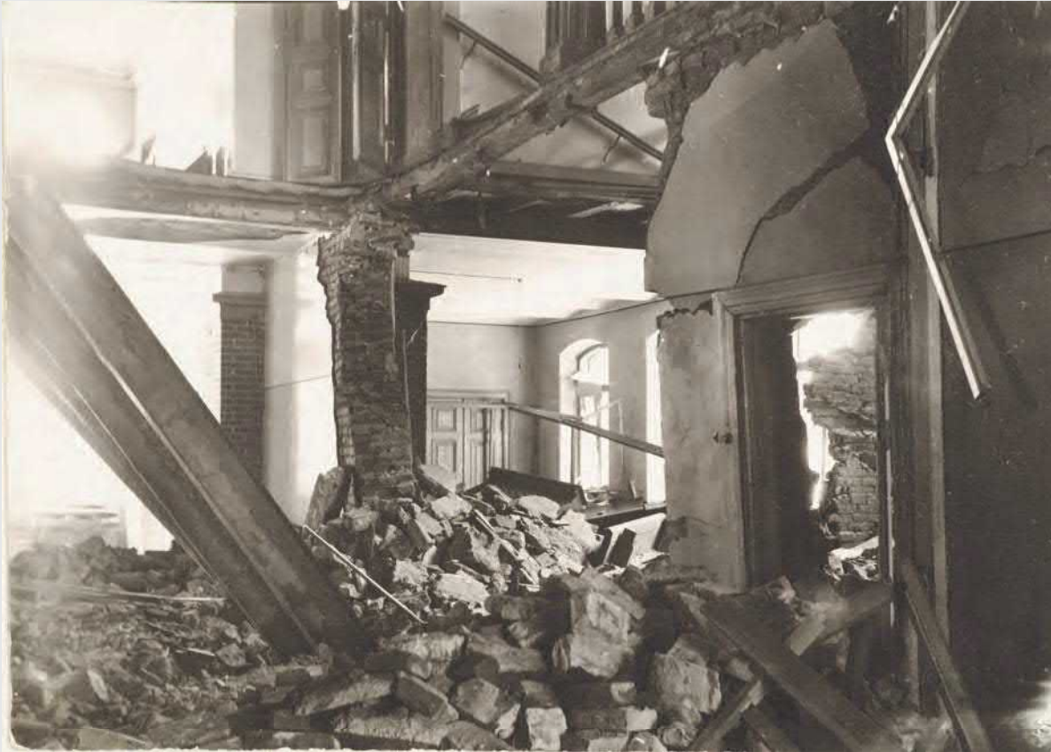
Talvisodan pommitukset vaurioittivat myös sokeainkoulua. Koulun alueelle pudotettiin 5.3.1940 pommeja, joista yksi tuhosi koulurakennuksen pääportaan ja siihen liittyvät ensimmäisen kerroksen muuratut seinät sekä romahdutti osan toisen kerroksen käytävän puurakenteisesta lattiasta. Kuvat on otettu keskikäytävältä lounaaseen (vasemmalla) ja länteen (oikealla). Kuvat: Kuopion kulttuurihistoriallinen museo
