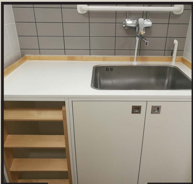
Esimerkki hoitopöytäkalusteesta, jossa riittävän syvä pesuallas ja integroidut tikkaat. (Päivärannan päiväkot)
