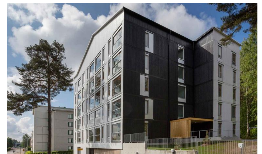
Esimerkkikuva parvekejulkisivusta, joka on sovitettu osaksi rakennuksen arkkitehtuuria, As Oy Pihapetäjä. Arkkitehtisuunnittelu: OPEAA. Kuva: Puuinfo.fi
