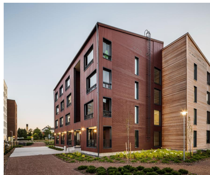
Esimerkkikuva yksiaineisesta julkisivusta, As Oy Kirkkonummen Tinankartano. Arkkitehtisuunnittelu: Lundén Architecture. Kuva: Puuinfo.fi
